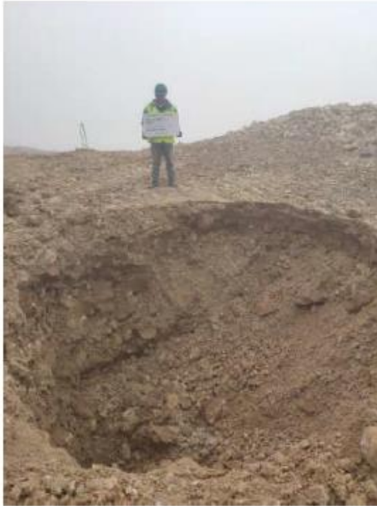
Foto N° 03: Calicata TP_ (TJ PV)19-103 - Backfill N°2.
