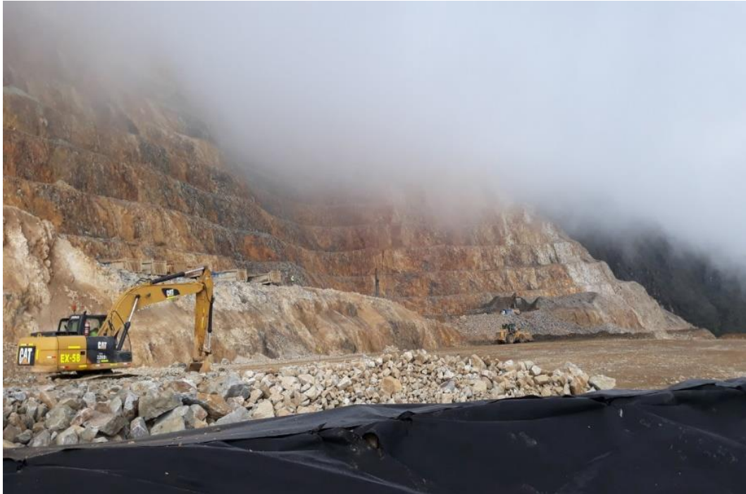
Imagen 04. Parte del Backfill 2 pampa verde
