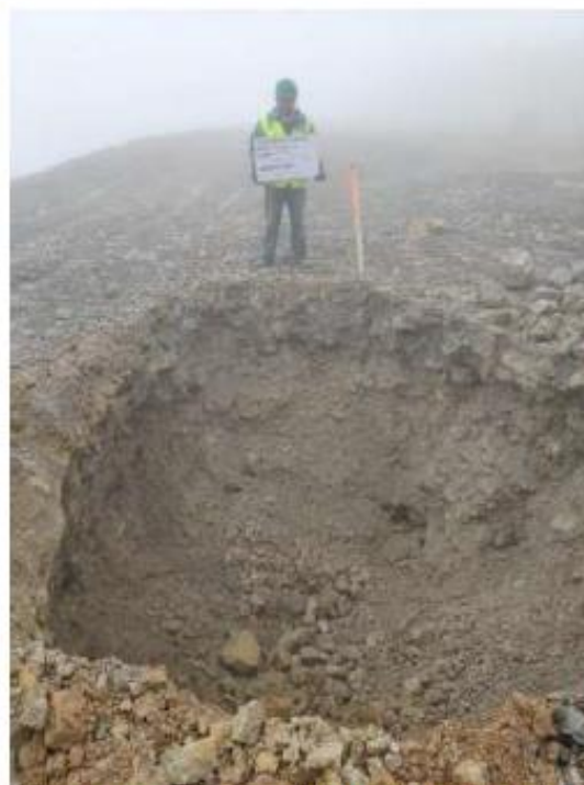
Foto N° 02: Calicata TP_ (TJ PV)19-102 - Backfill N°1.
