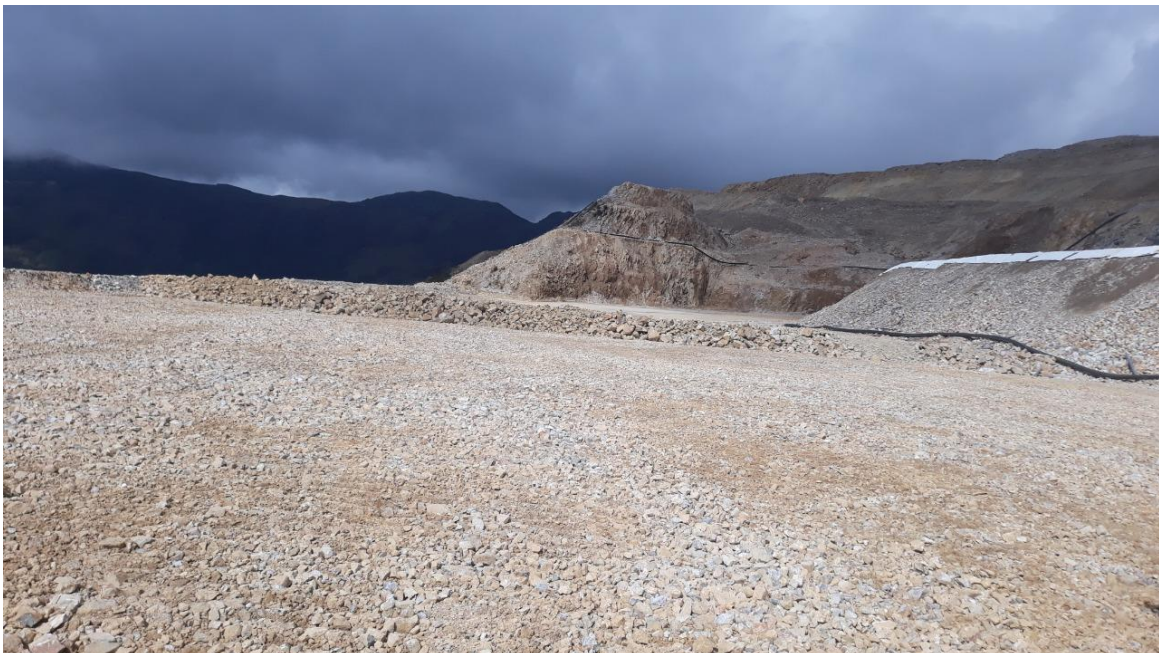
Imagen 10. Capa de Backfill
