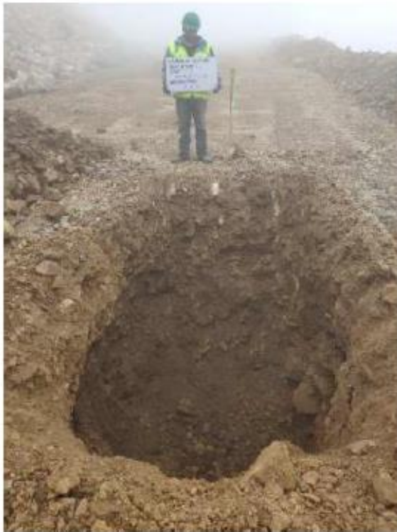
Foto N° 05: Calicata TP_(TJ PV)19-105 - Backfill N°1.
