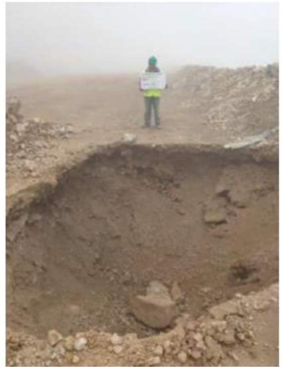
Foto N° 06: Calicata TP_(TJ PV)19-106 - Backfill N°1.
