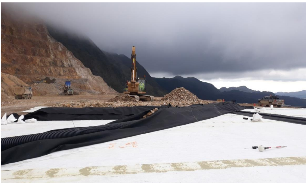
Imagen 08. Área de cubierta de geomembrana de Backfill
