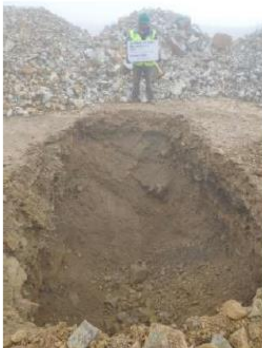
Foto N° 01: Calicata TP_ (TJ PV)19-101 - Backfill N°2.
