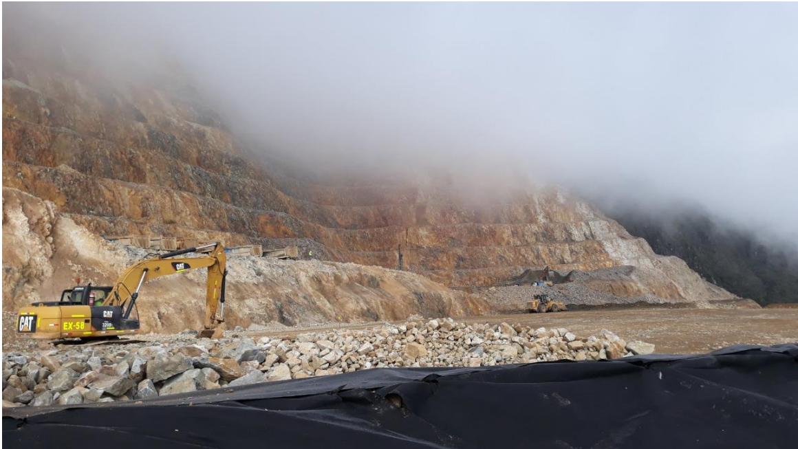
Imagen 09. Área de cubierta con relleno en Backfill
