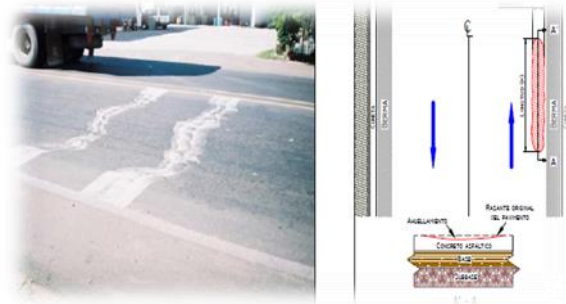
Figura 9: Ahuellamiento
