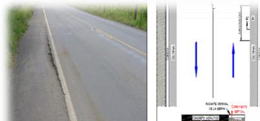
Figura 17: Separación de la Berma
