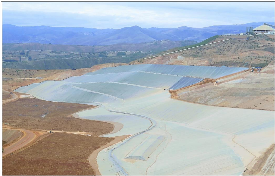
Vista panorámica Pad Fase 2 sector sur (vista desde el mirador norte)
