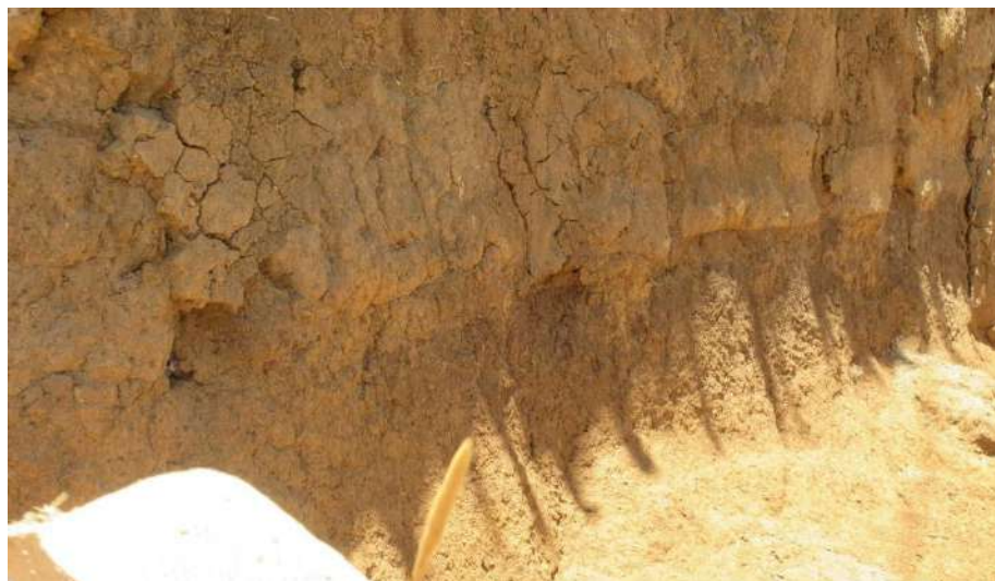
Figura 41. CM-03 BASES EROSIONADAS
