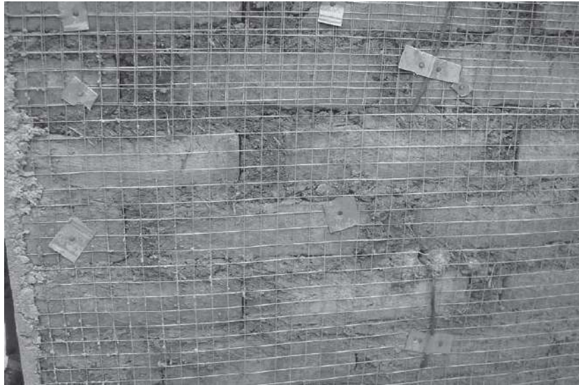
Figura 33. MALLAS METALICAS PARA REFUERZOS DE MUROS DE TIERRA
