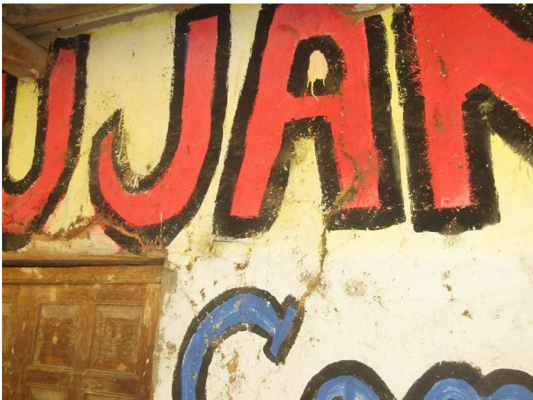
Figura 60. FISURAS EN PORTADA PRINCIPAL
