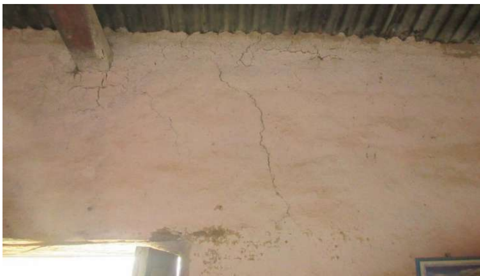
Figura 37. CM-05 FALLA POR FLEXION
