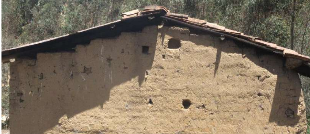
Figura 44. CM-04 MUROS EXTERNOS PERFORADOS
