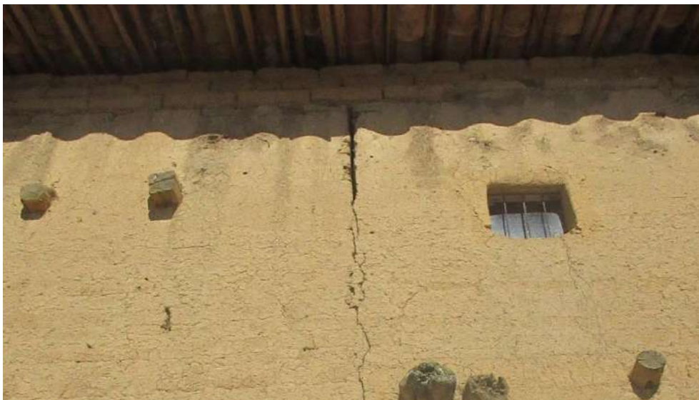
Figura 36. CM-10 FALLA POR TRACCION
