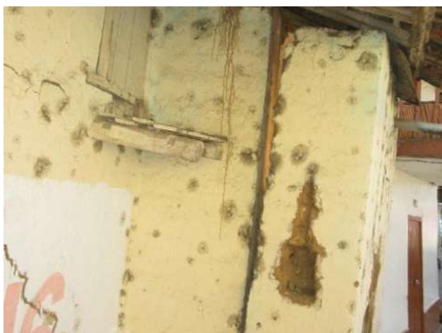
Figura 35. CM-05 FALLA POR TRACCION
