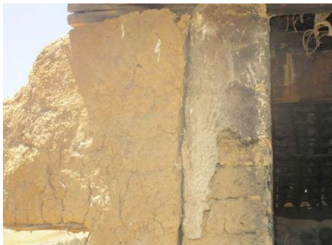
Figura 34. CM-01: FALLA POR TRACCION
