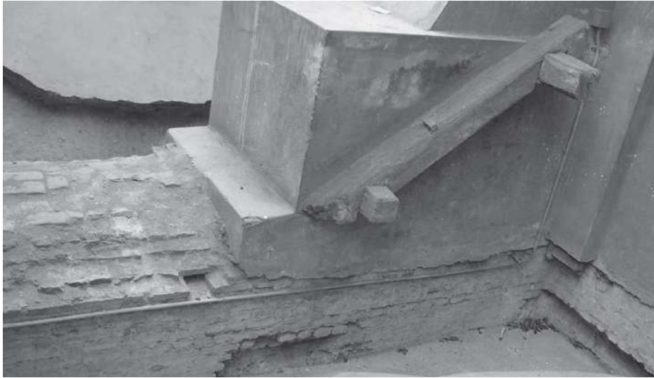
Figura 31. LLAVE DE REFUERZO DE MADERA APLICADO EN LOS CONTRAFUERTE
