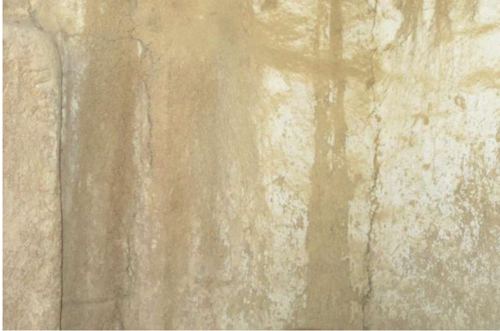
Figura 38. CM-08 FALLA POR FLEXION
