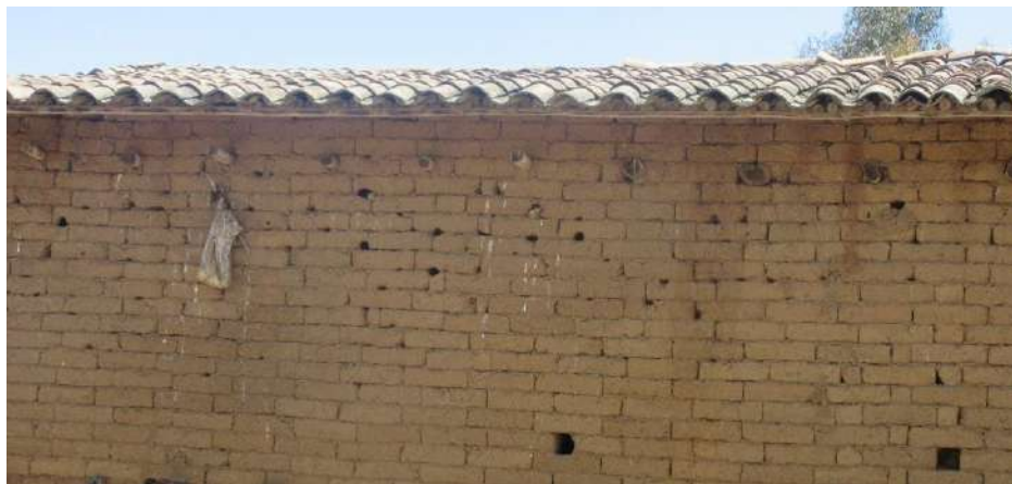
Figura 43. CM-01 MUROS PERFORADOS
