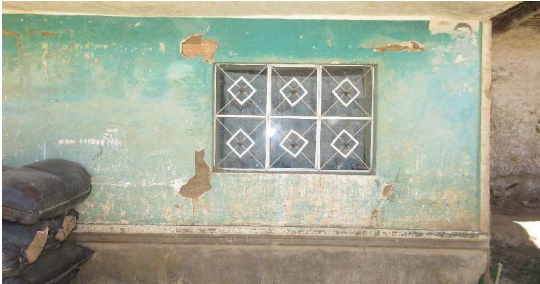
Figura 59. FALLA POR FLEXION EN MURO EXTERNO
