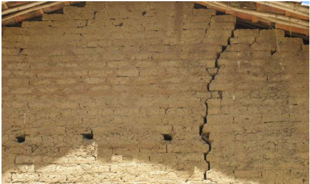
Figura 39. CM-07 FALLA POR CORTE
