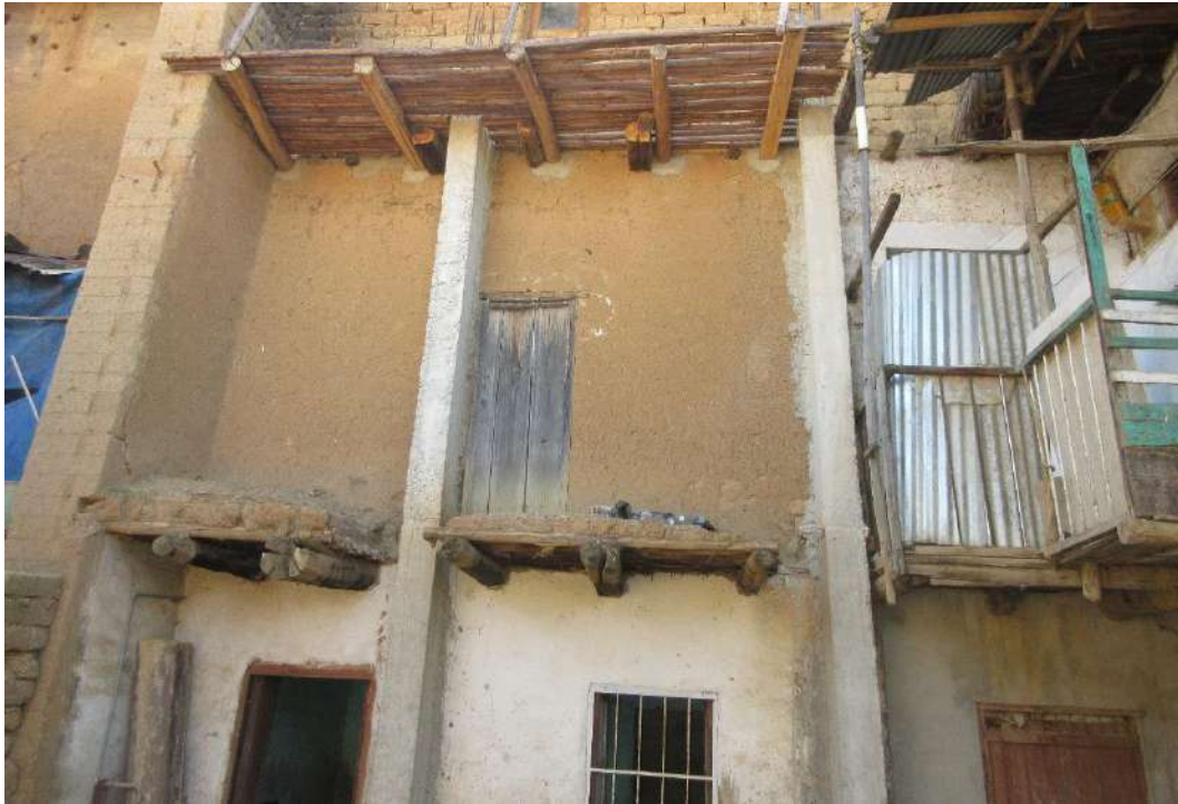
Figura 55. VIVIENDA REFORZADA CON COLUMNAS DE CONCRETO ARMADO
