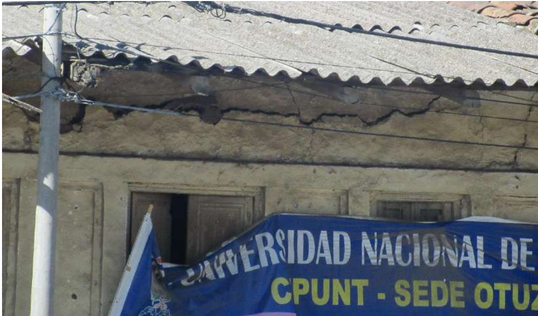
Figura 57. VIVIENDA DE ALTO RIESGO
