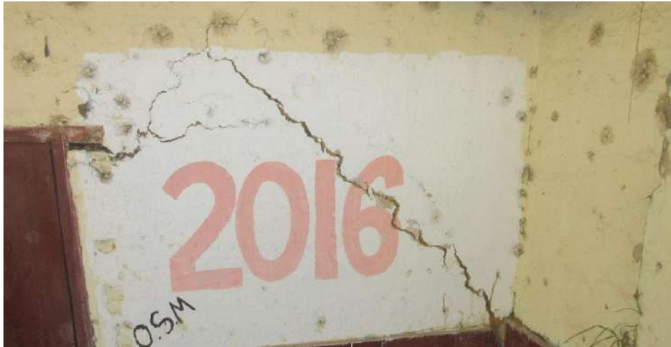
Figura 40. CM-05 FALLA POR CORTANTE
