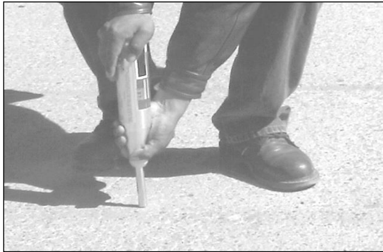
Figura N°18.2. Ensayo con el equipo de esclerómetro
