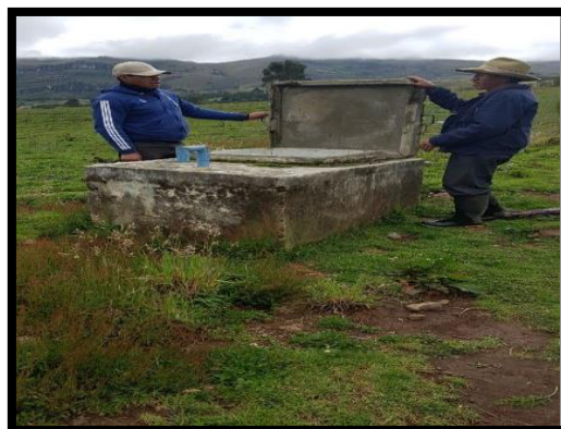
Imagen Nº 03: Reservoirio Existente Nº02 – Sector Nueva Esperanza
