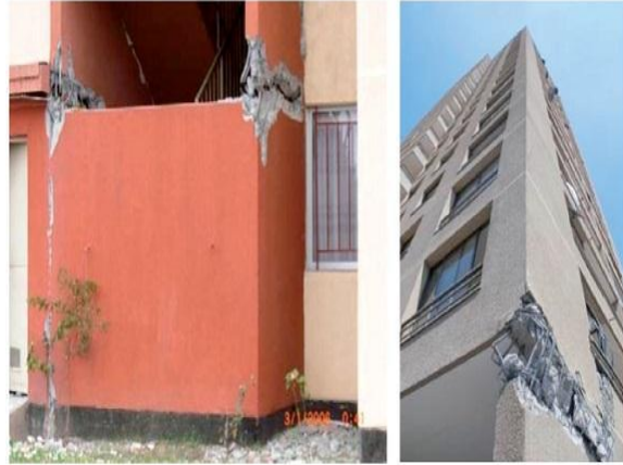
Figura N° 04: Falla por corte en muros de concreto.
