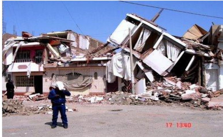
Figura N° 07: Falla de edificaciones por insuficiente número de columnas.
