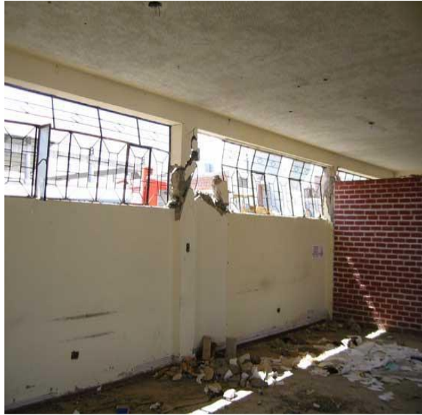
Figura N° 06: Falla por columna corta en una columna.
