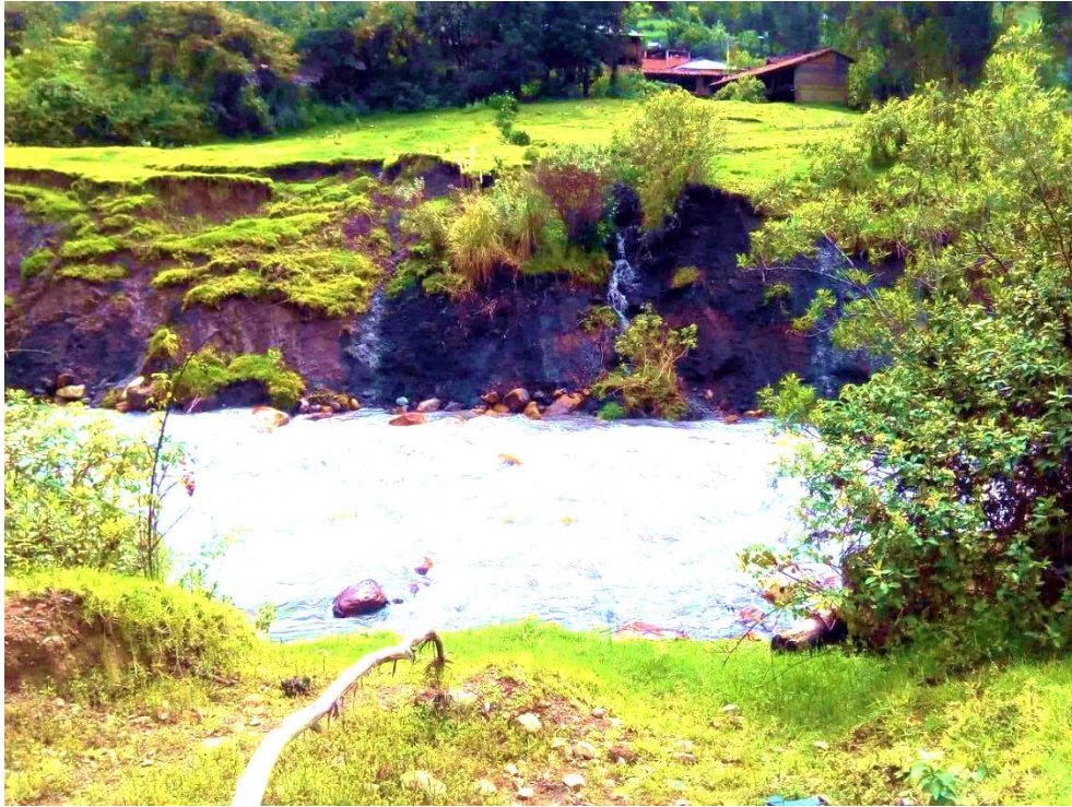
FOTO N.º 02: DESLIZAMIENTO POR EL RIO
