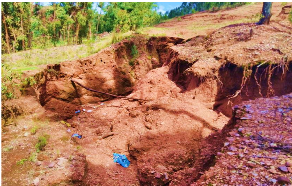
FOTO N 04 DESLIZAMIENTO DE TIERRA
