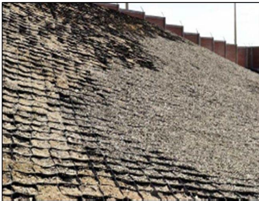
Figura 3: Sistema de geoceldas con relleno de concreto
