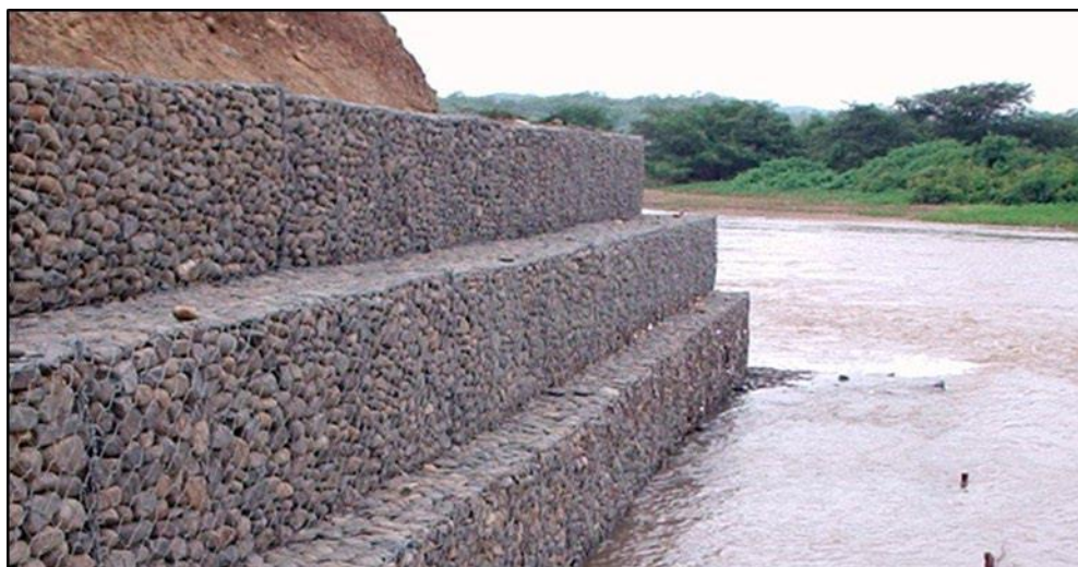
FIGURA 5: malla de Gaviones con relleno de piedra
