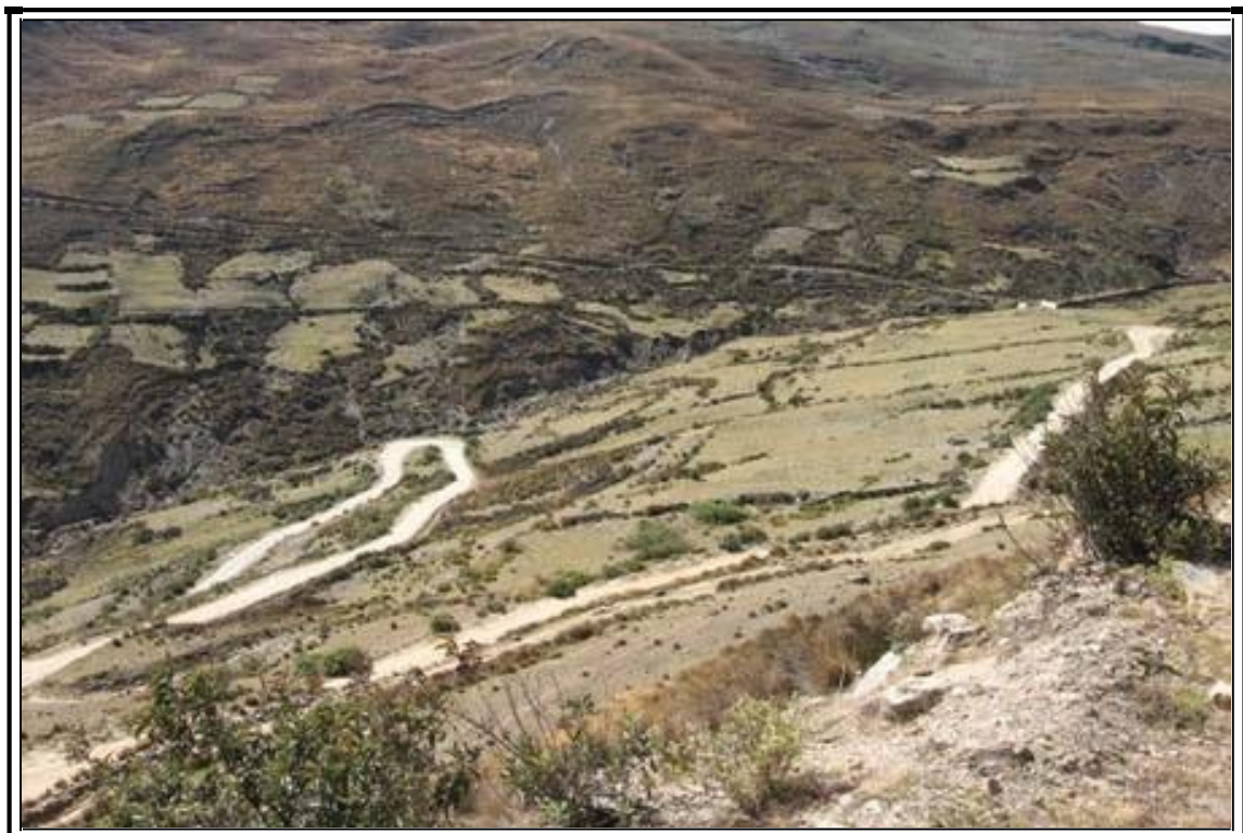
Figura N°02 Se observa en la figura desarrollo de la carretera Km.10+000
