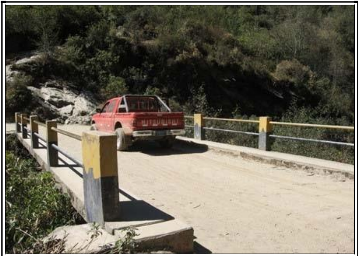
Figura N°01 Se observa en la figura el puente tanatamayo Km.1+700
