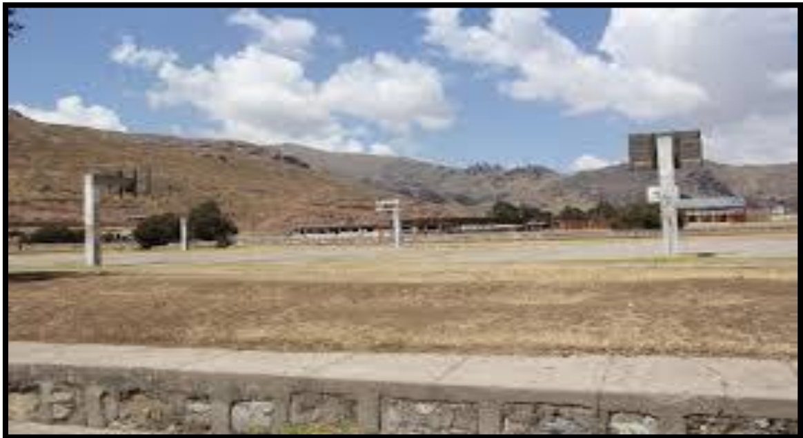
Imagen 01.-Se observa el mal estado de las canchas de básquet
