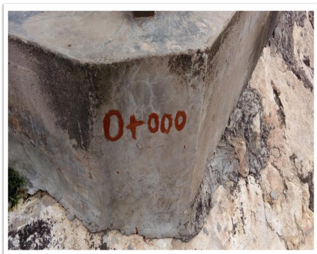
Imagen N° 1 pintado de la progresiva 0+000
