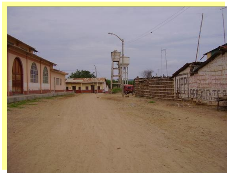
Inicio Km 0+000, realización de la primera calicata
