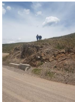
Tramo: Palca-Vila Vila, km05+685
