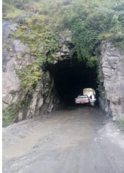
Tramo: Cuyo Cuyo-Sandia, Km13+500
