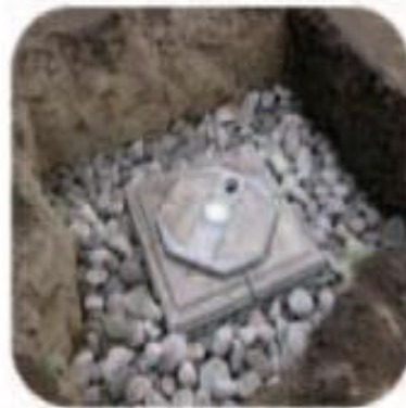
Vertical tipo pozo de absorción.
