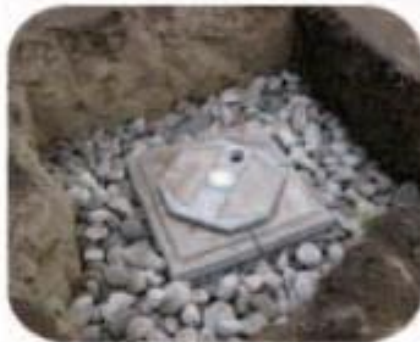
Vertical tipo pozo de absorción.
