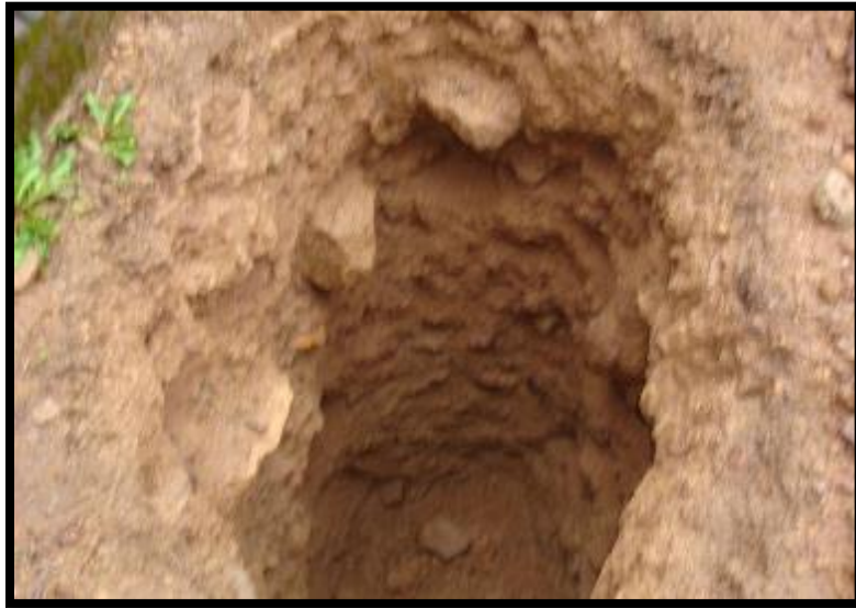
IMAGEN 11: CALICATA RESERVORIO (AHIJADERO)
