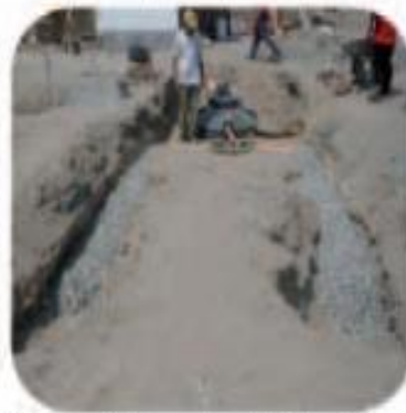
Horizontal tipo zanjas de infiltración.
