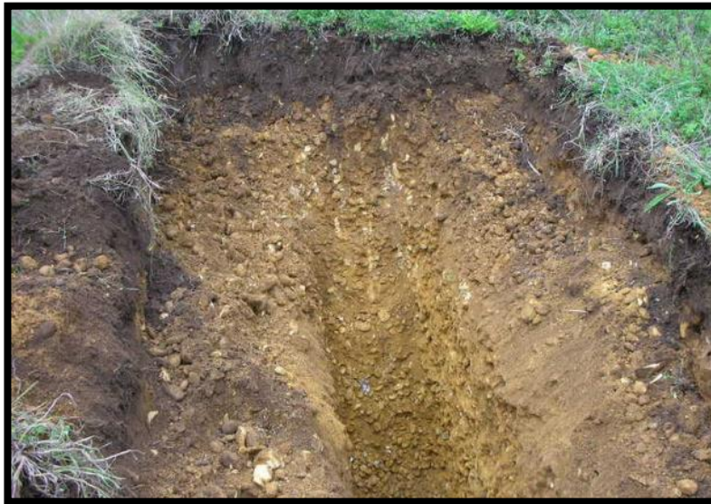
IMAGEN 10: CALICATA RESERVORIO (CHAQUICOCHA)
