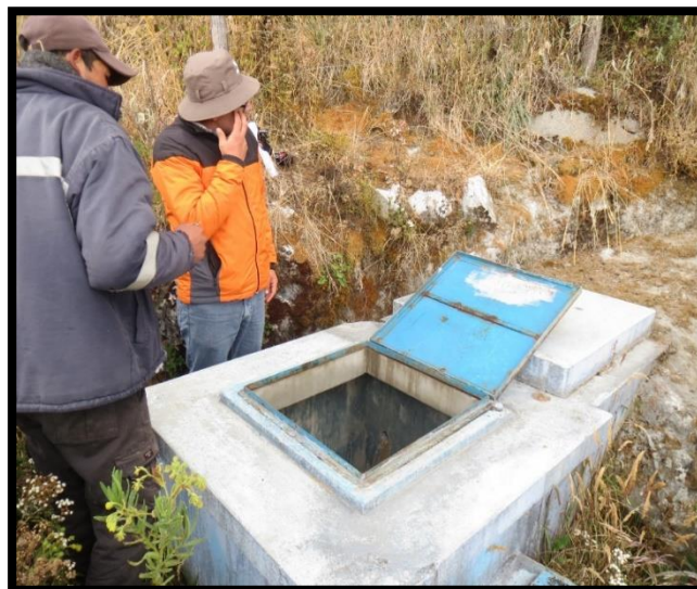
IMAGEN 06: CAPTACION DE CHAQUICOCHA
