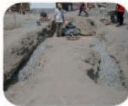
Horizontal tipo zanjas de infiltración.
