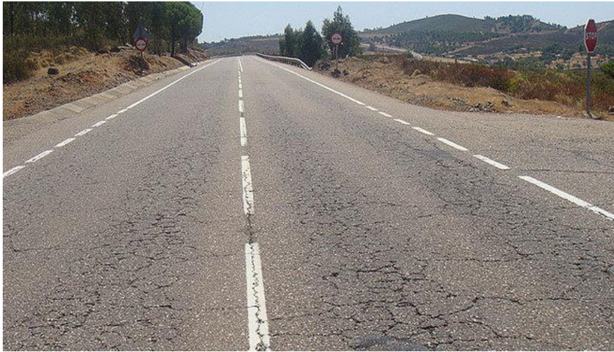
Ilustración 10: falla desprendimiento de agregados
