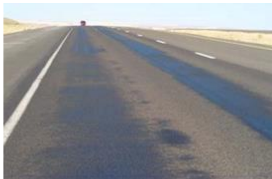
Ilustración 11: falla por exudación
