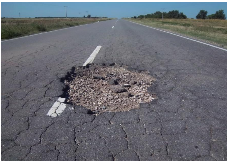
Ilustración 9: falla por huecos
