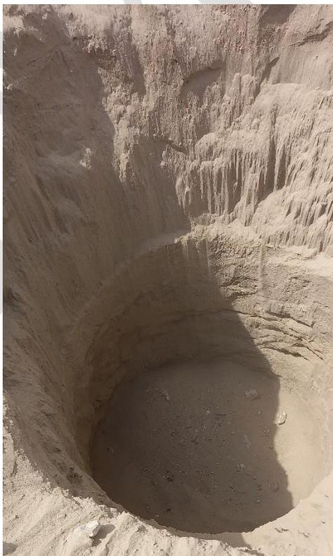
FOTO 4: CALICATA TERMINADA A LA PROFUNDIDAD INDICADA DE 3 M
