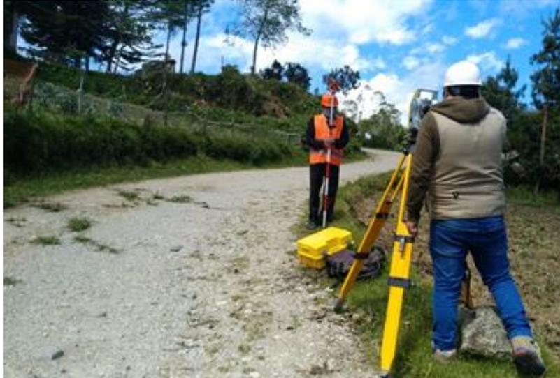
**Figura 5:** Toma fotográfica del levantamiento topográfico en trocha.
