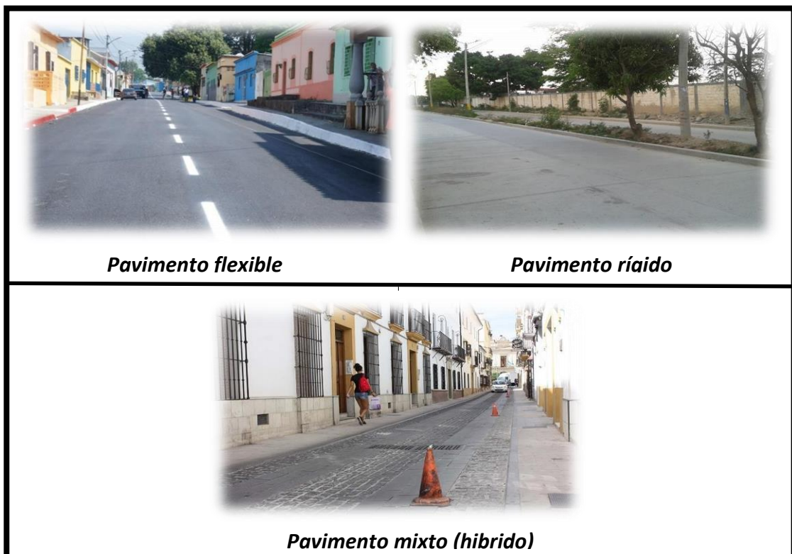
Figura 4 visualizamos los 3 principales tipos de pavimentos descritos anteriormente: pavimento flexible, rígido y mixto (híbrido).
