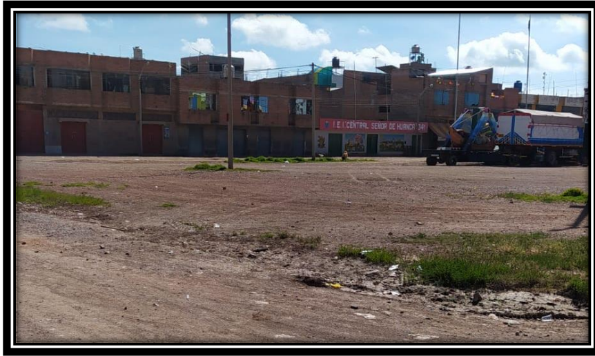
FIGURA N o 06: Tipo de Viviendas del Distrito de San Miguel
