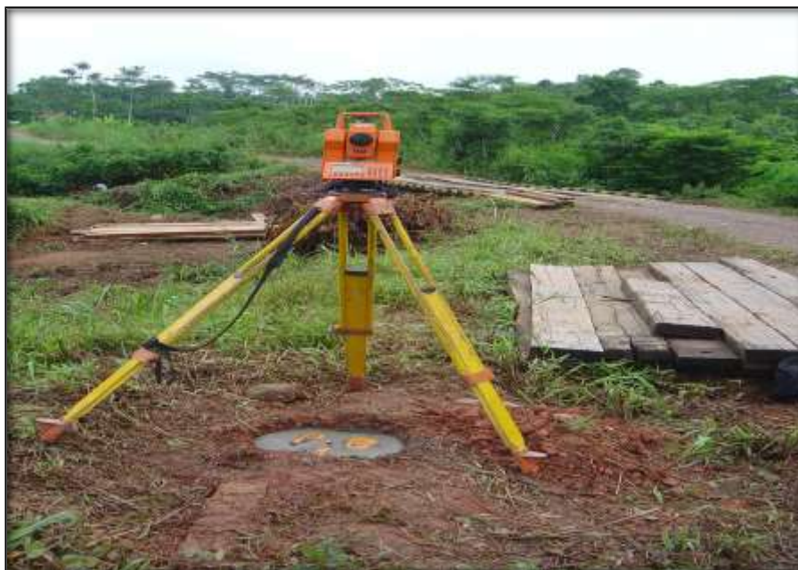
FIGURA N°18 Equipo utilizado para el Levantamiento topográfico
