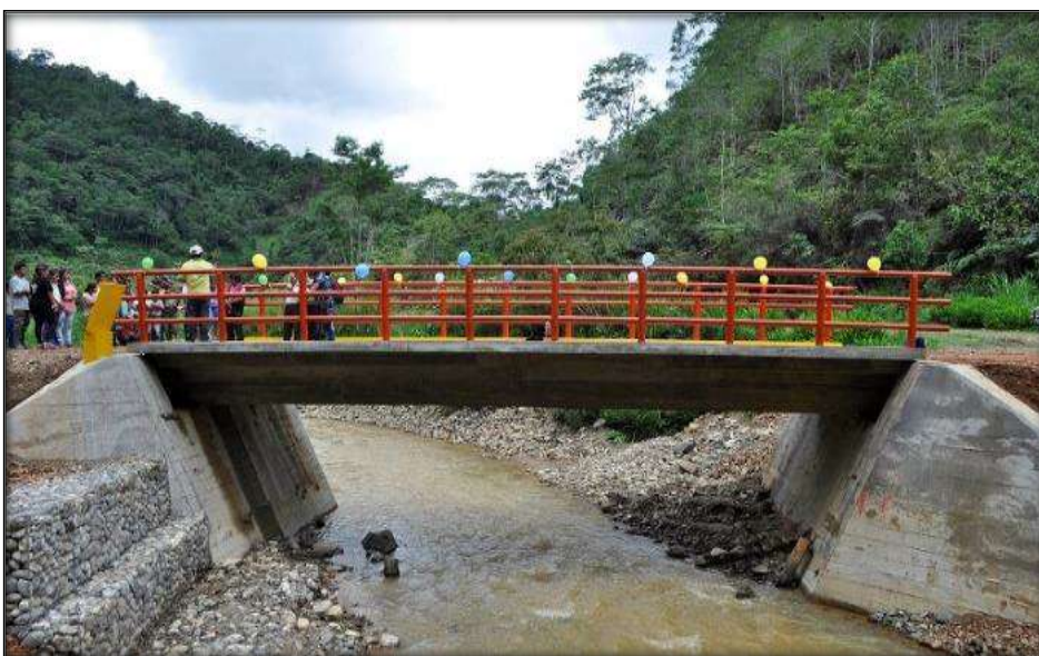
FIGURA N°06 Puente de Concreto Simplemente Apoyado
