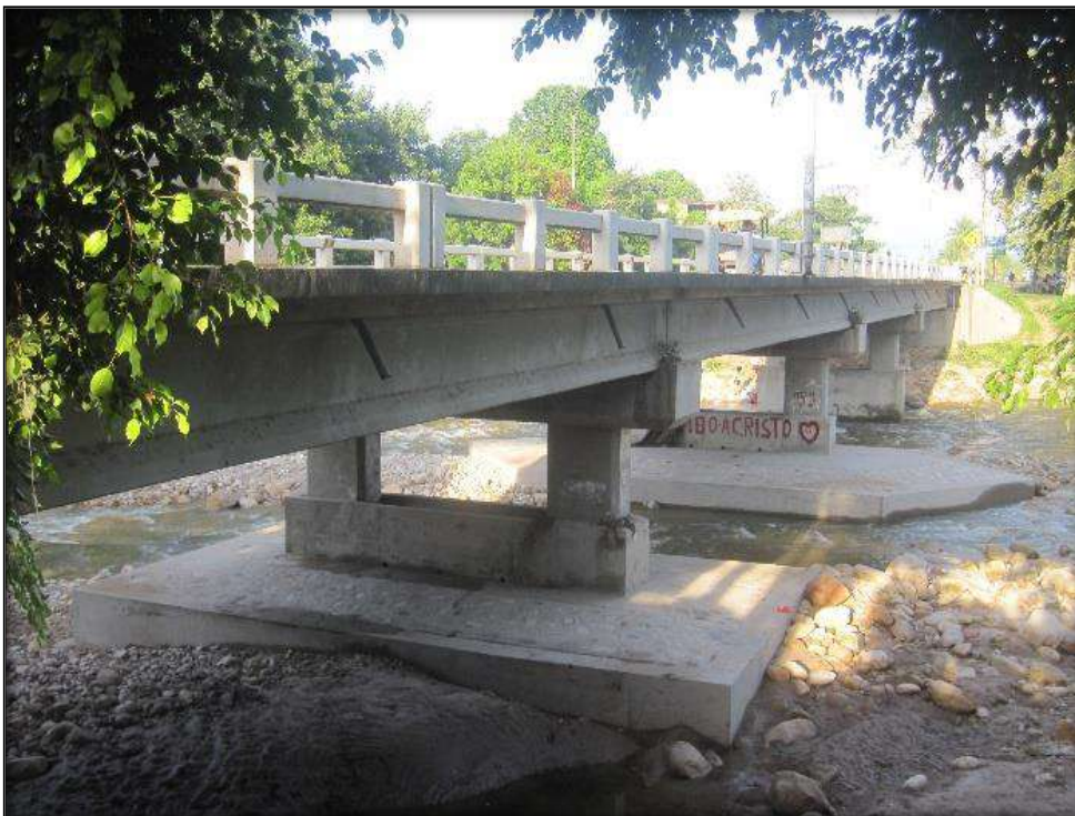
FIGURA N°08 Puente simplemente Apoyado de 3 tramos
