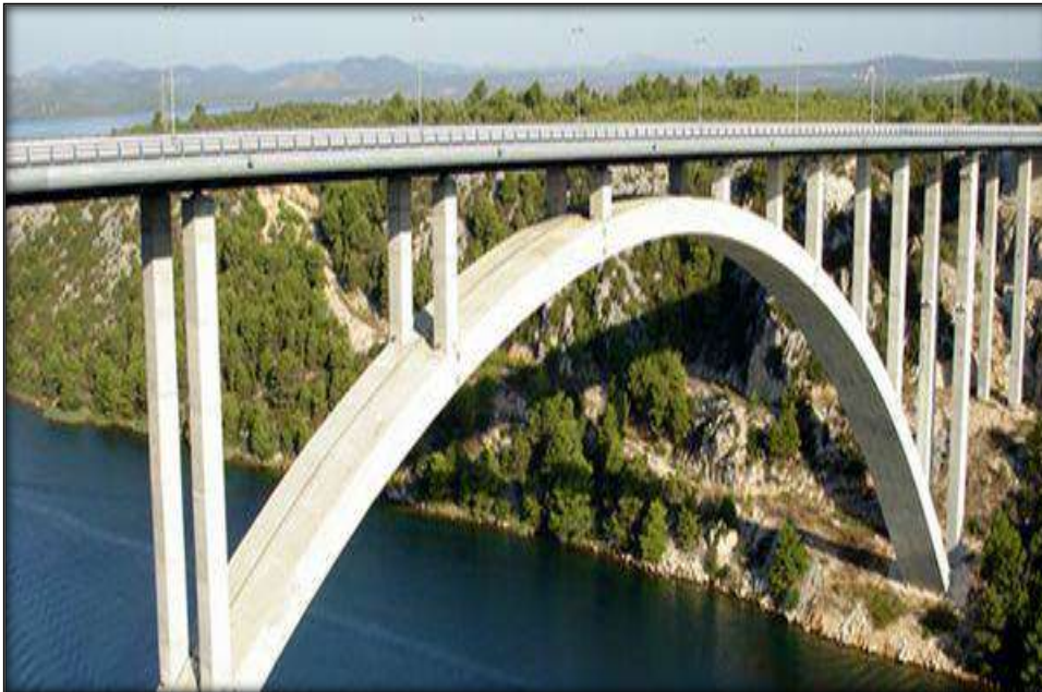
FIGURA N°07 Puente Arco de Concreto
