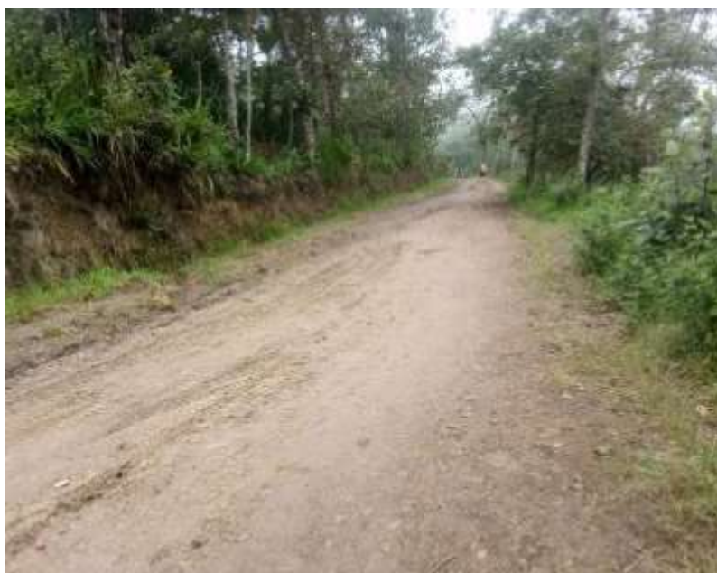
Figura 28: Tramo carretera situación actual
