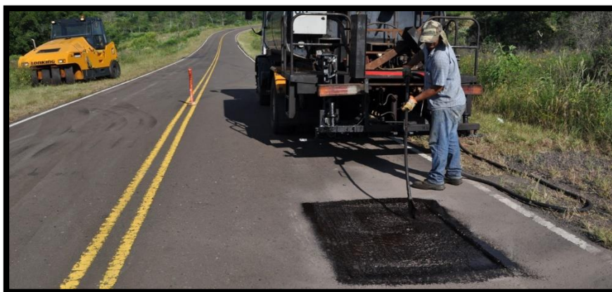
Figura 05. Bacheo superficial y profundo.
