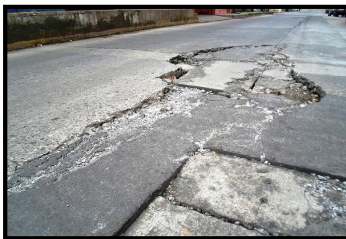
Figura 28. Peladura.
