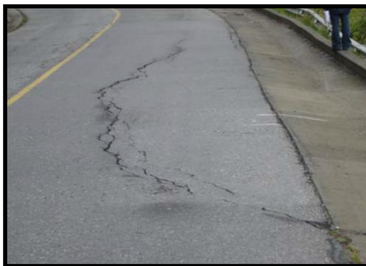
Figura 26. Fisura parabólica.
