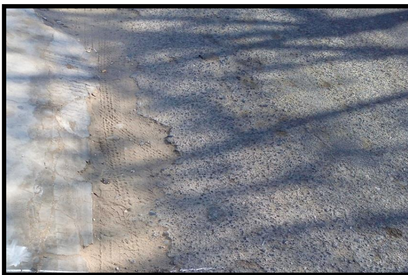
Figura 15. Fisuras de borde.
