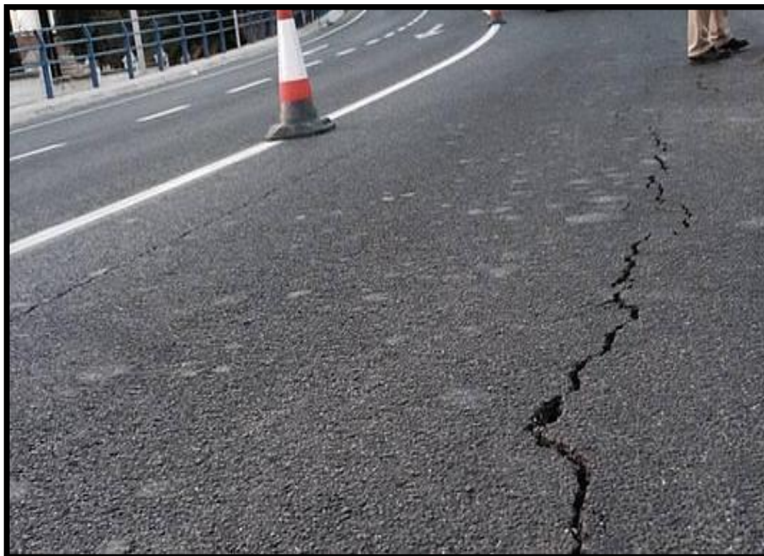
Figura 18. Fisuras longitudinales.
