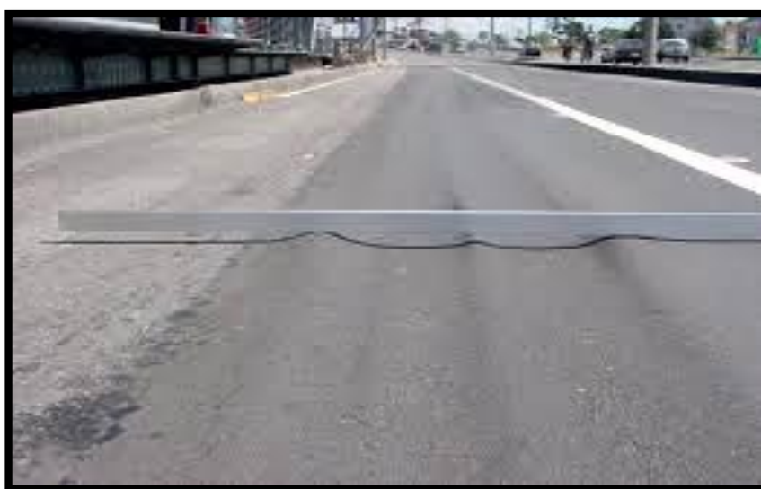
Figura 24. Ahuellamiento.
