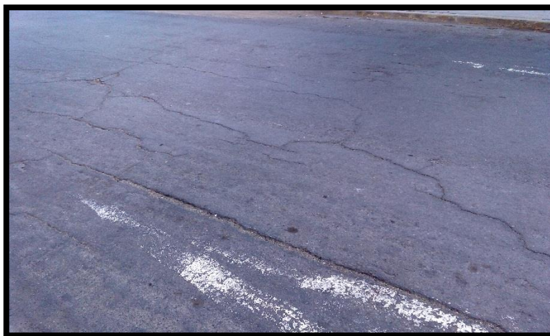
Figura 10. Fisuras en bloque.
