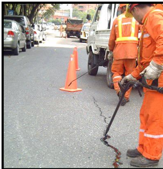
Figura 04. Sellado de grietas.
