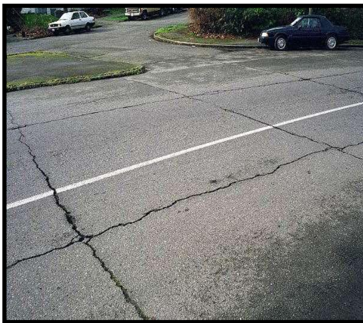
Figura 16. Fisura de reflexión de junta
