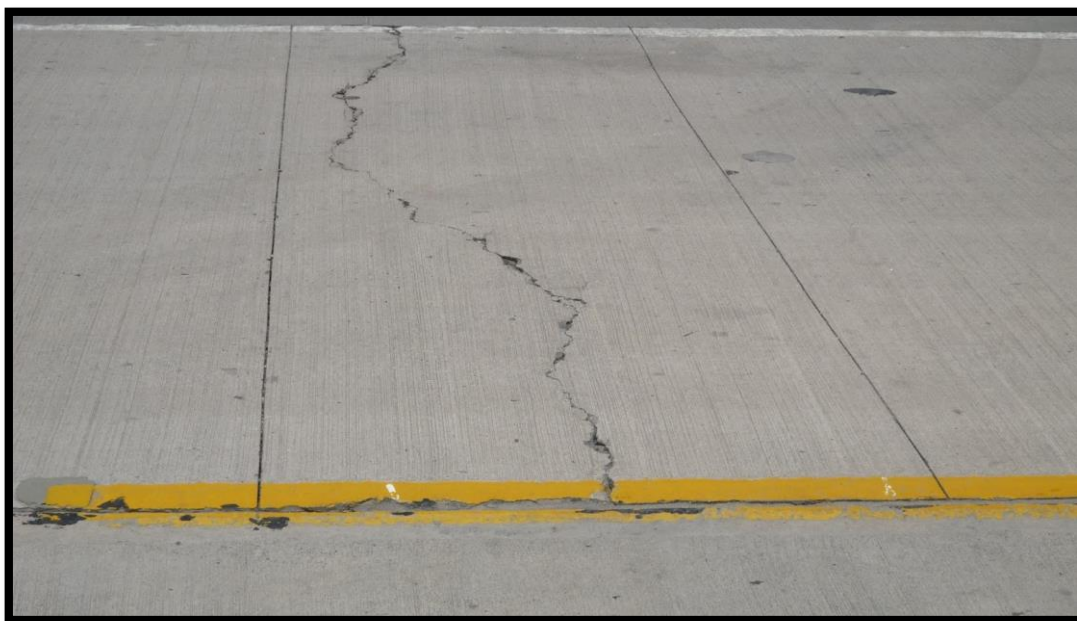
Figura 19. Fisuras transversales.
