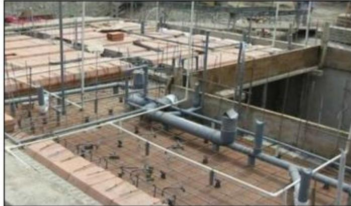
**Colocado de malla de temperatura** Se coloca la malla de temperatura de acero de 1/4" o 6 mm como se muestra en la Figura 09, la ubicación de esta malla es sobre la bovedilla. Asimismo, se deben colocar dados o separadores de concreto, para evitar levantar la malla durante el vaciado del concreto, ya que la malla no puede quedar pegada a la bovedilla y de esta forma permita el ingreso del concreto de forma uniforme.
