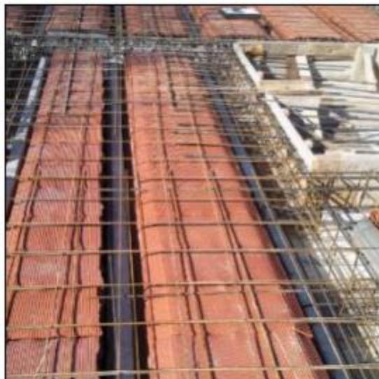
**Limpieza y mojado** Con el objetivo de mejorar la adherencia del concreto, se debe limpiar la superficie de las viguetas mediante un riego antes del vaciado de la capa de compresión como se muestra en la Figura 10.
