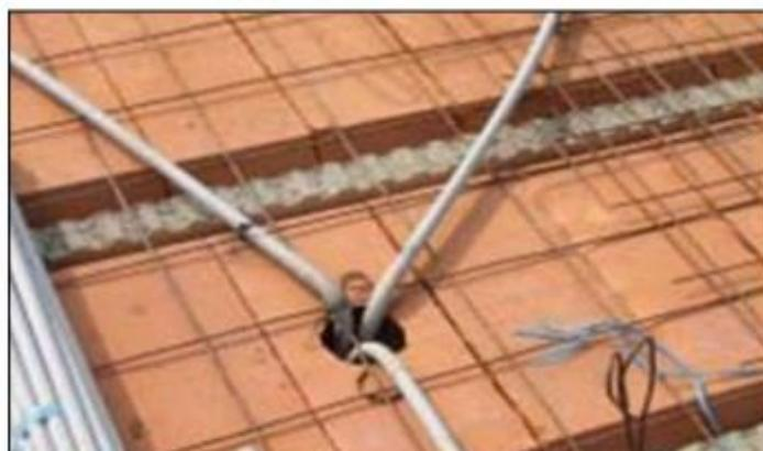
Figura 08: Instalaciones sanitarias con viguetas pretensadas
