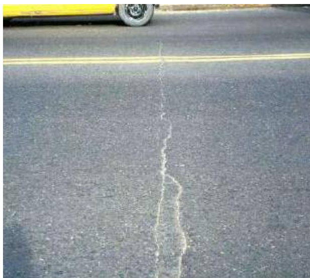
Figura 16. Fisura transversal
