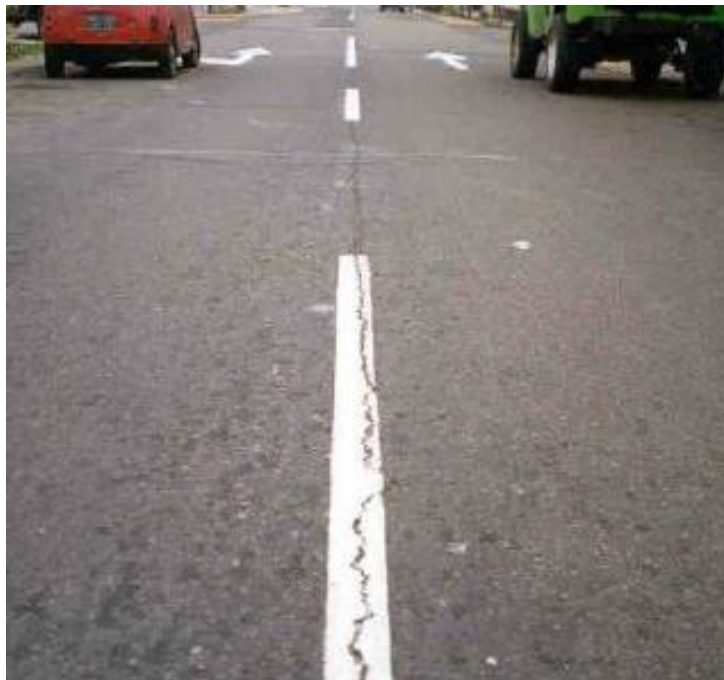
Figura 15. Fisura longitudinal
