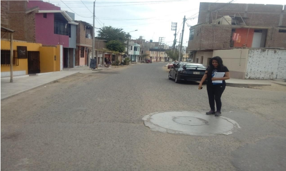
Fotografía N° 3: Av. Mateo de Toro y Zambrano (Buzón roto y emanando malos olores)
