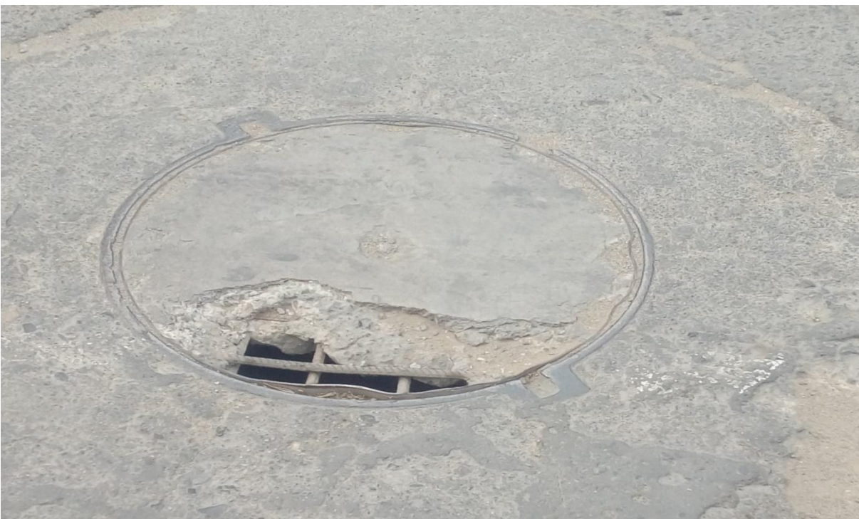
Fotografía N° 8: Buzón de la Fotografía N° 7
