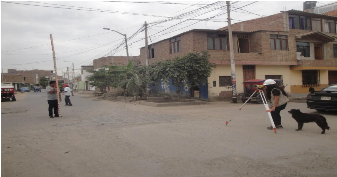
Fotografía N° 16: Levantamiento topográfico en nuevos puntos buzones Calles Alfonso Ugarte con Haití
