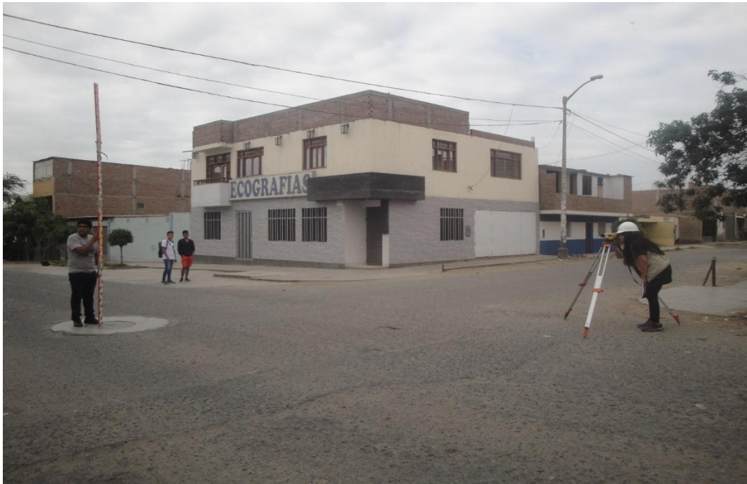
Fotografía N° 12: Levantamiento topográfico en buzón existente
