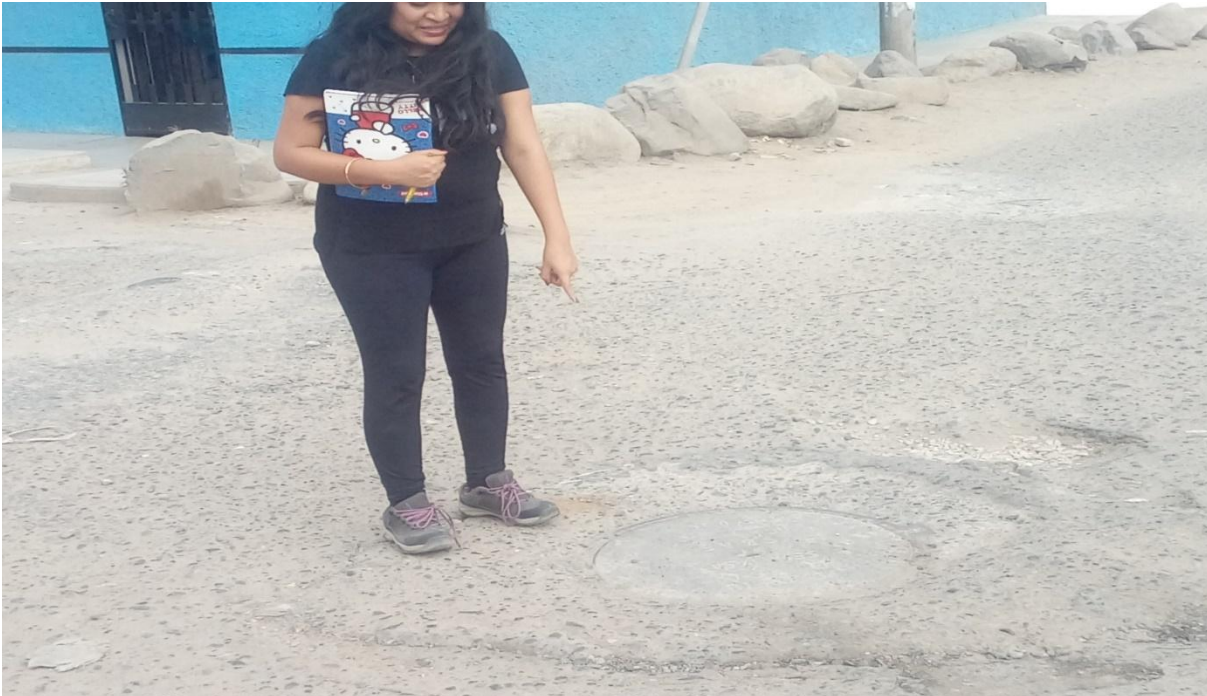
Fotografía N° 5: Hundimiento de Buzón en Pasaje Bardales
