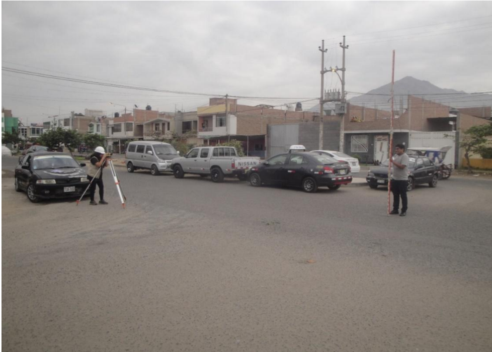
Fotografía N° 10: Levantamiento topográfico en nuevos puntos buzones proyectados (Av. Chancay)
