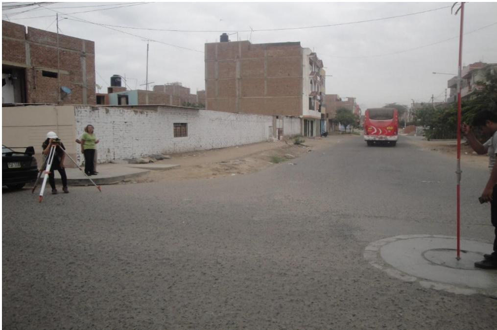
Fotografía N°13: Levantamiento topográfico en buzón existente Buzón a doble chorro
