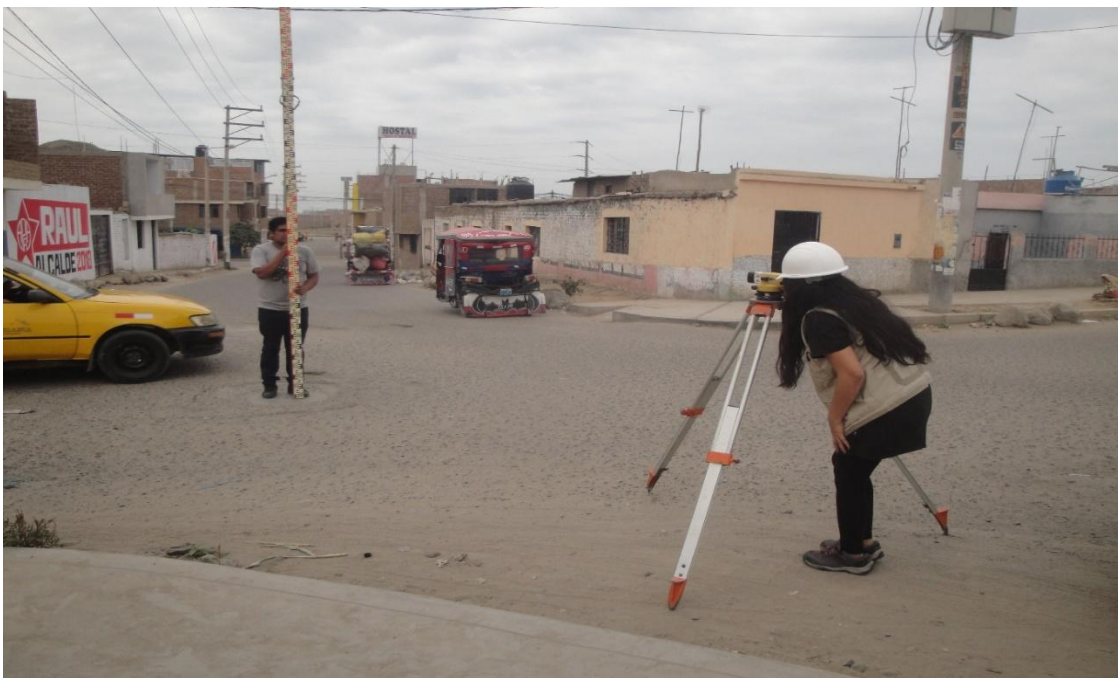
Fotografía N°15: Buzón 44 existente en Calle Salvador con Toro y Zambrano.
