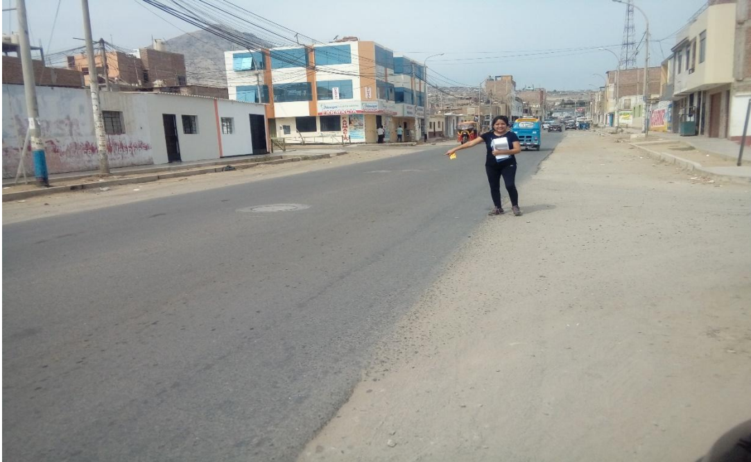
Fotografía N°1: Buzón N° 1 Ubicado en Av. Egipto
