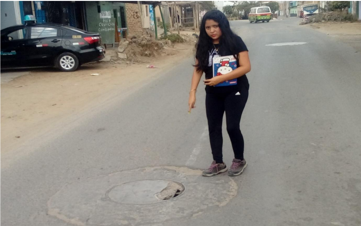
Fotografía N° 7: Buzón en mal estado (Calle Victoria)
