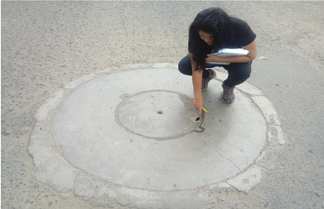
Fotografía N° 4: Buzón N° 32 en mal estado ubicado entre la Av. M. de Toro y Av. Chancay
