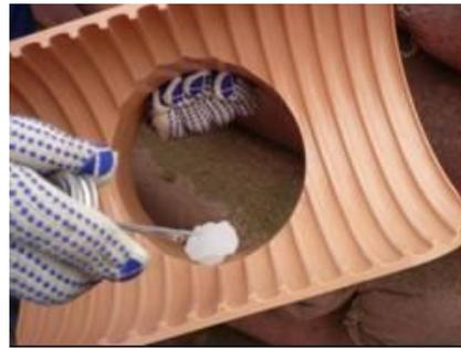
Figura 18.aplicación del cemento disolvente.
