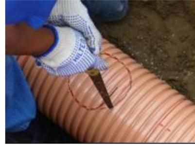
Figura 15. Perforación de la tubería.
