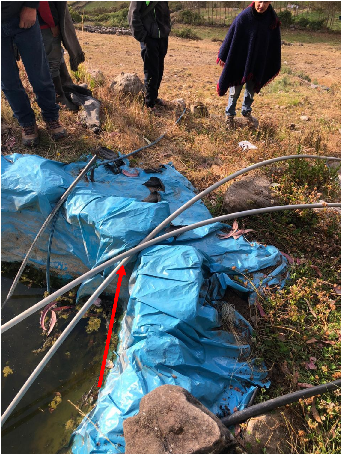
Figura 14. Se observa la forma rudimentaria de transporte de agua hacia los micro reservorios Fuente: elaboración propia
