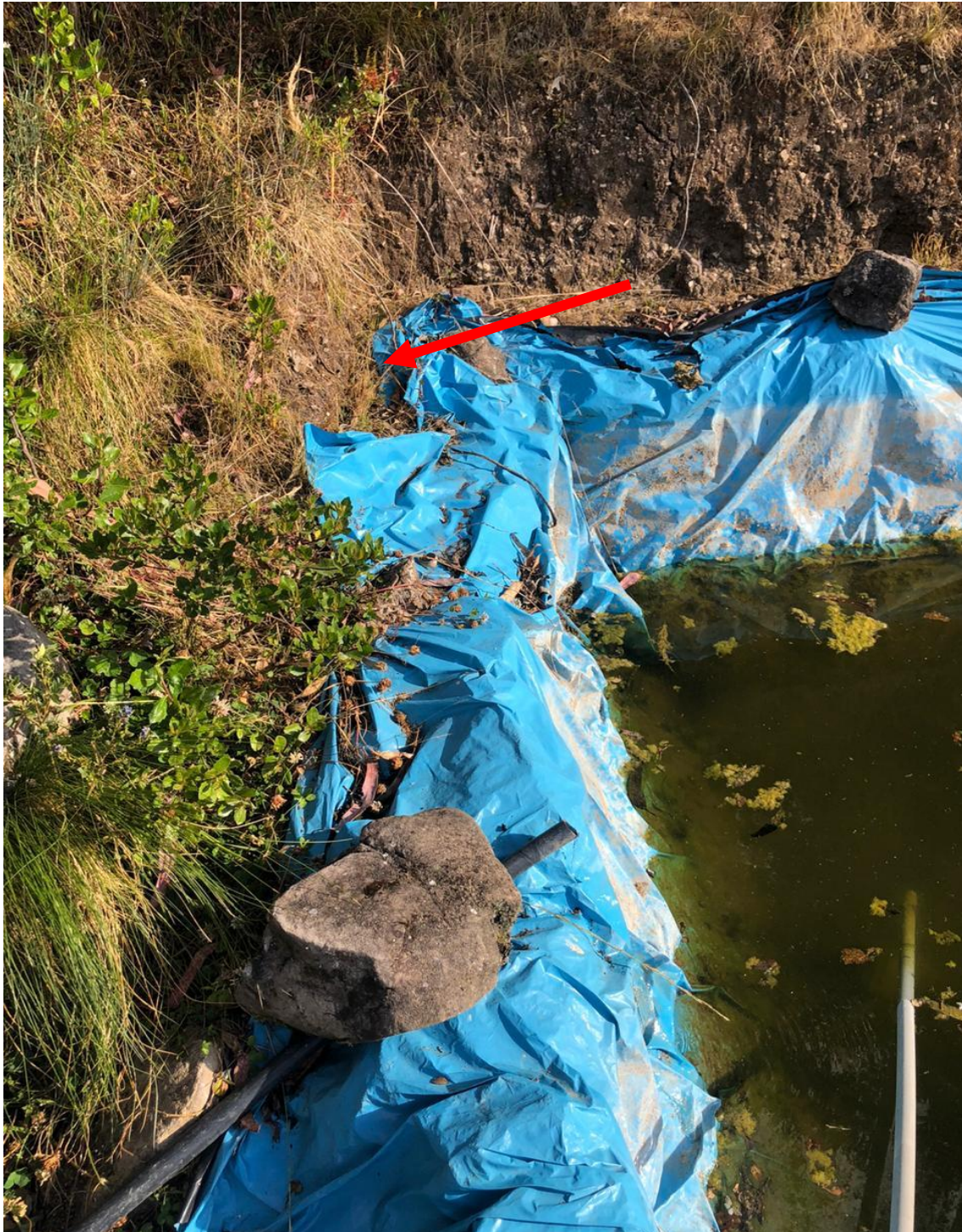
Figura 15. Se observa la falta de perfilado de los micro reservorios. Fuente : elaboración propia
