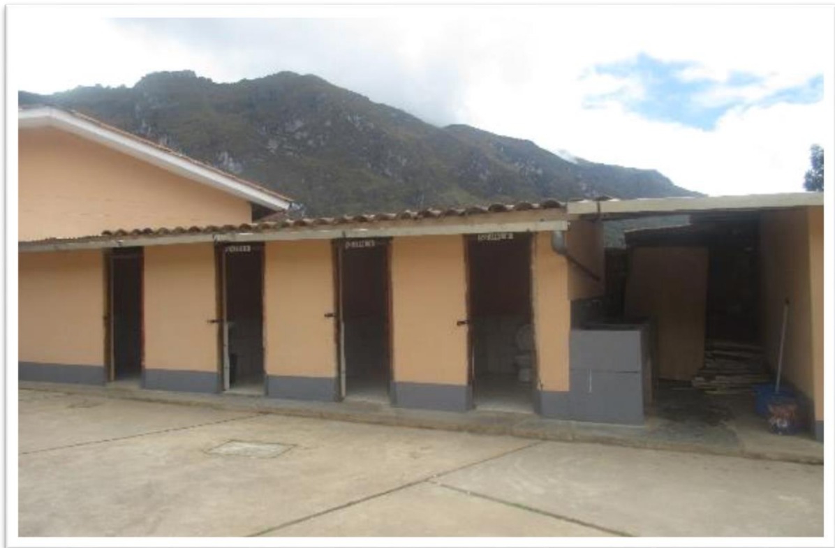
Figura 45. Vista de ambientes existentes. Fuente: propia.
