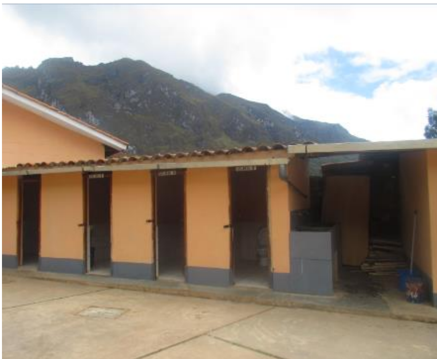
Figura 13. Vista exterior del módulo 4 – Secundaria. Fuente: propia.
