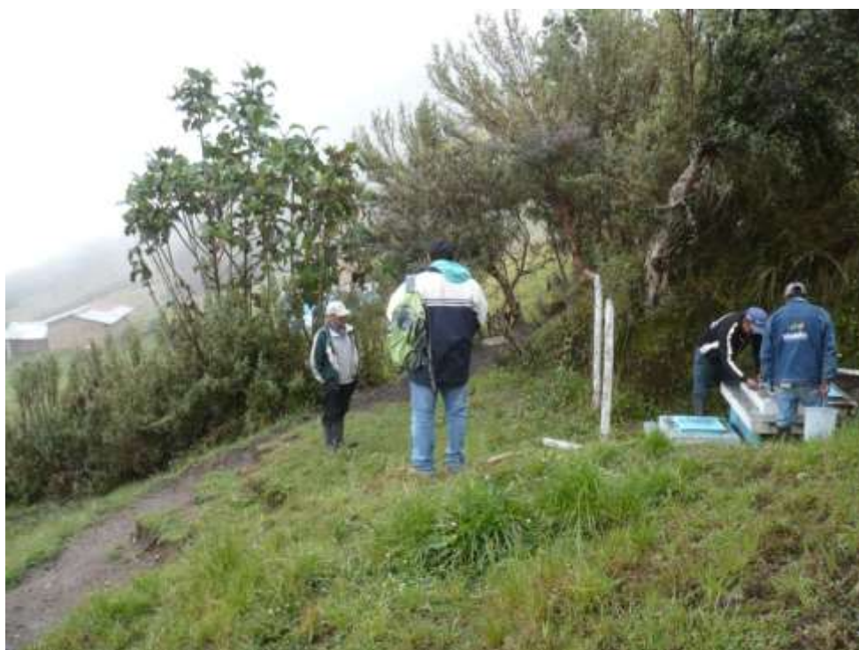
Foto N° 01.- CAPTACION “Cueva Negra” – 0.90 lps.
