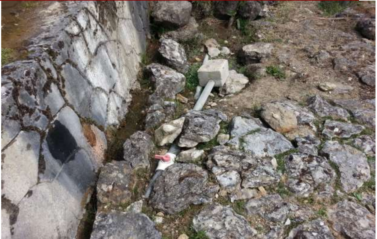
FOTO N° 09. - CONEXIÓN DE REBOSE Y LIMPIEZA DE RESERVORIO.
