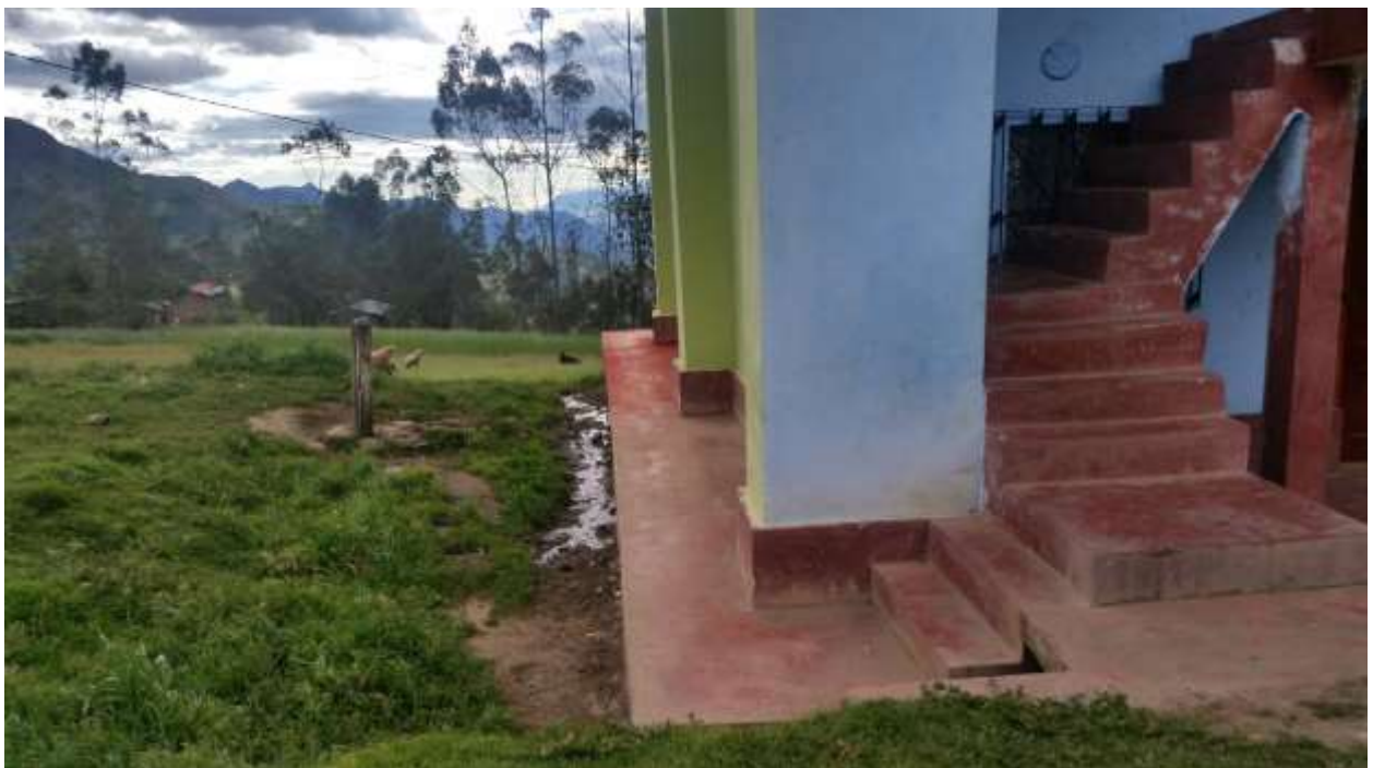
FOTO N° 28. - PILETA EN INSTITUCION EDUCATIVA PRIMARIA
