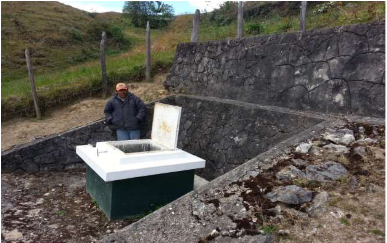
FOTO N° 01. - CAPTACION N° 1 "UÑIGAN".
