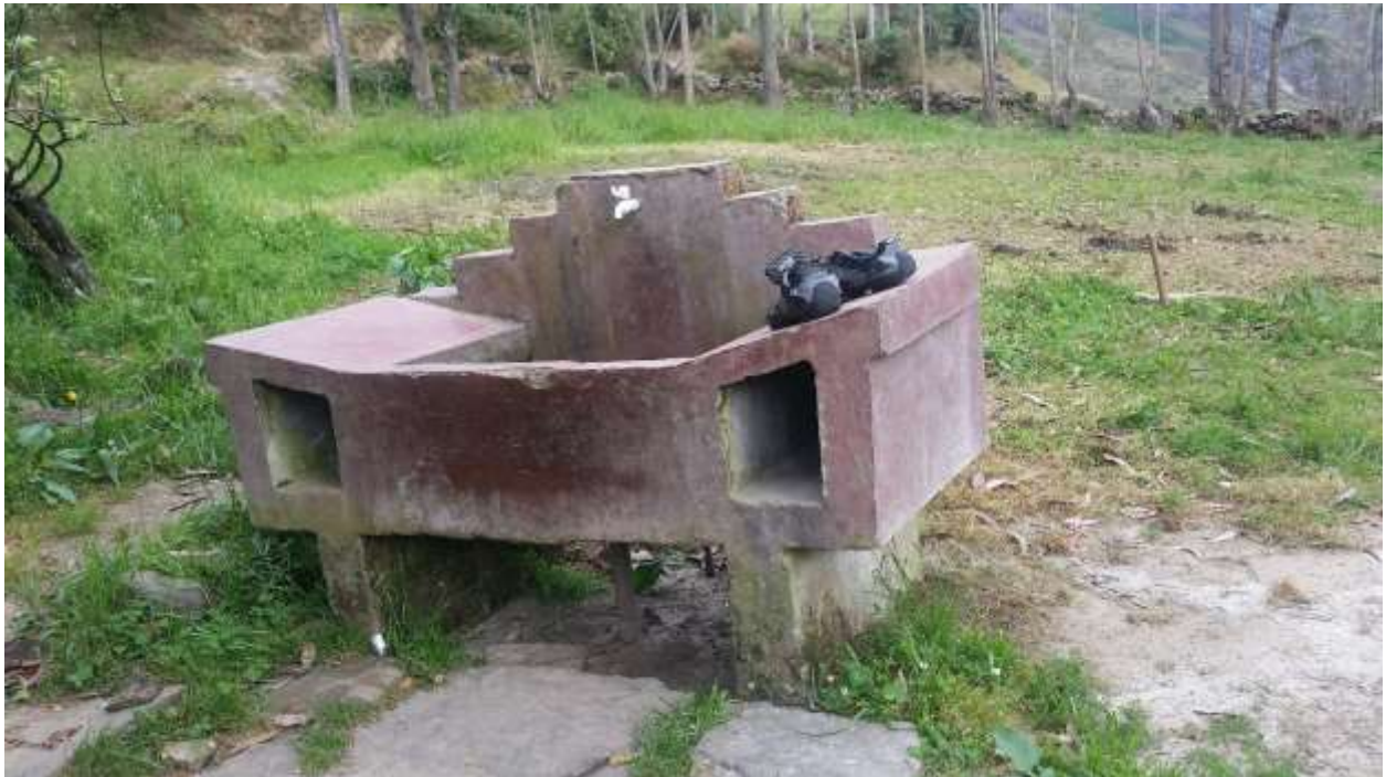
FOTO N° 15. - PILETAS TIPO LAVATORIO EN SITUACION DE COLAPSO
