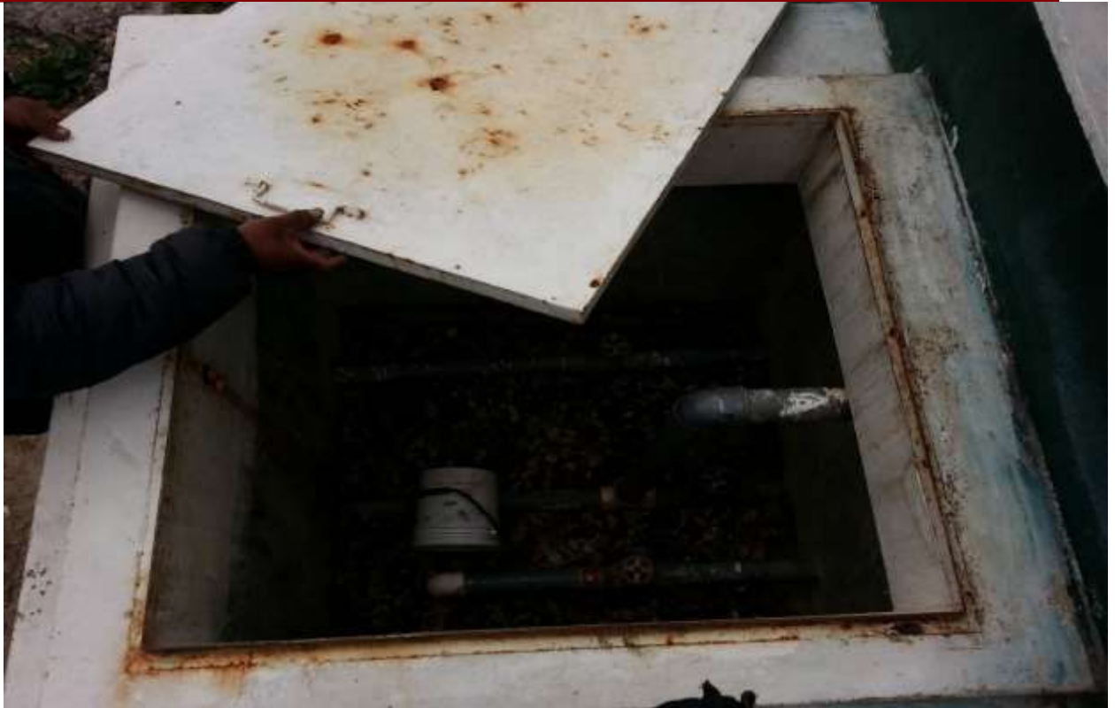
FOTO N° 11. - VISTA EXTERIOR DE CASETA DE VALVULAS DE RESERVORIO
