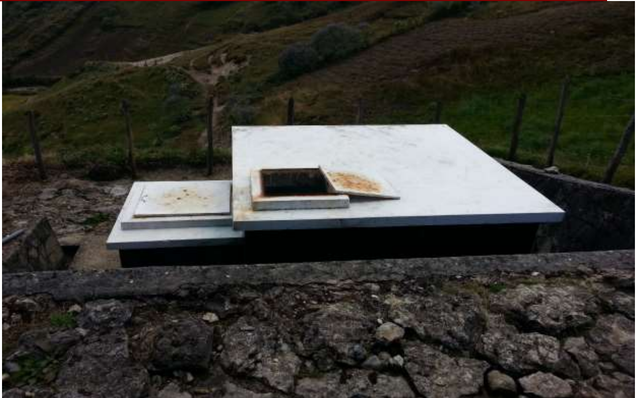
FOTO N° 07. - VISTA DE RESERVORIO
