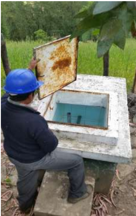
FOTO N° 19. - VISTA DE CRP T-7. TAPA METALICA E INTERIOR
