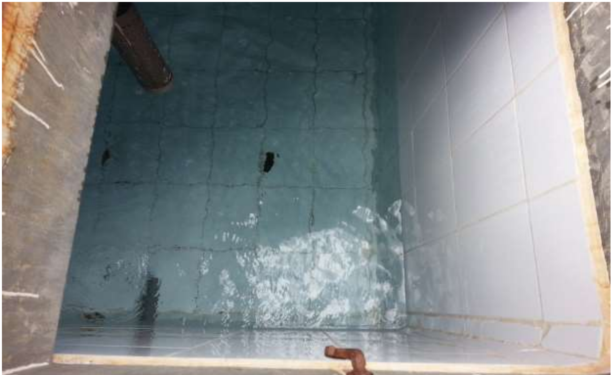
FOTO N° 10. - VISTA INTERIOR DE RESERVORIO
