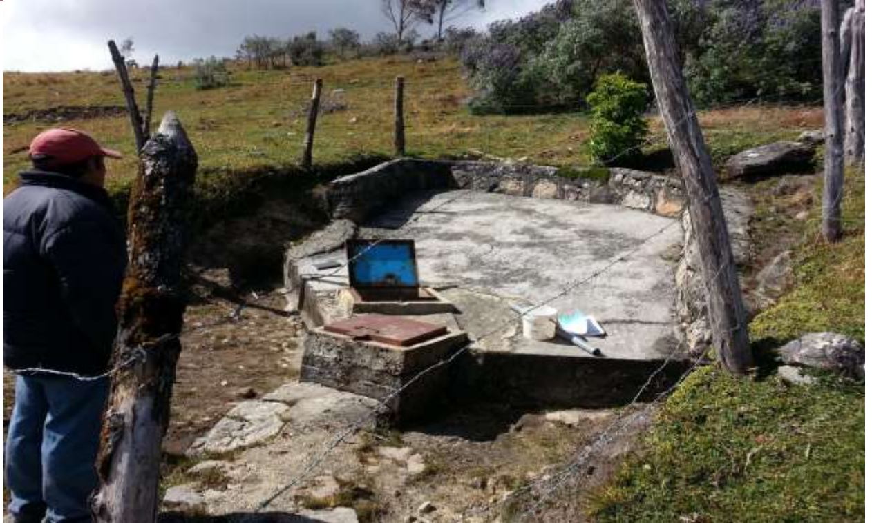
FOTO N° 03. - CAPTACION N° 3 “LA TOTORA”.
