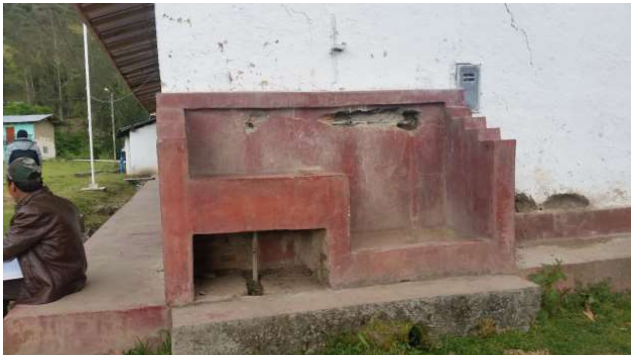
FOTO N° 26. - PILETA EN INSTITUCION EDUCATIVA INICIAL
