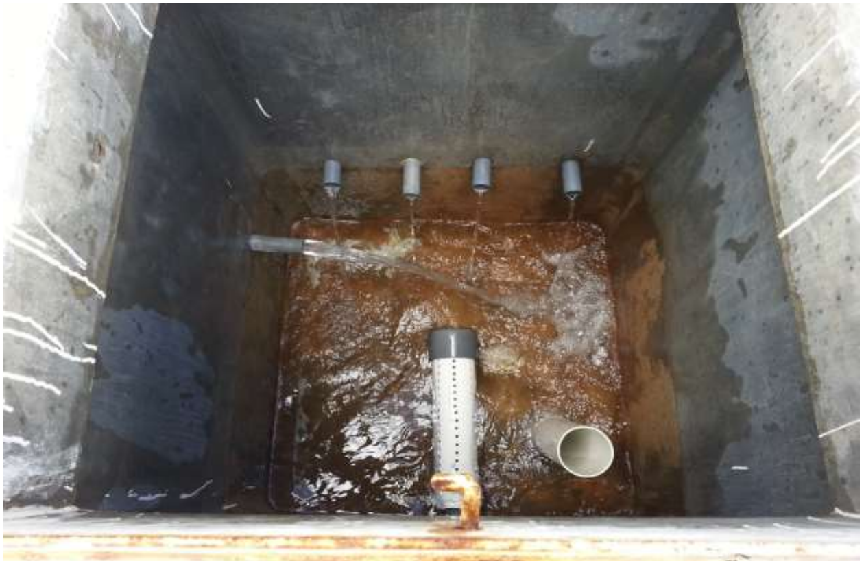
FOTO N° 04. - VISTA INTERIOR DE CAPTACION
