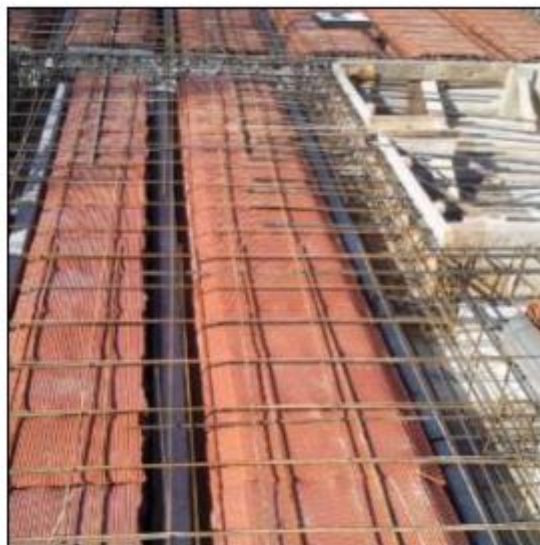
Figura 09: Malla de temperatura en losa con vigueta pretensada
