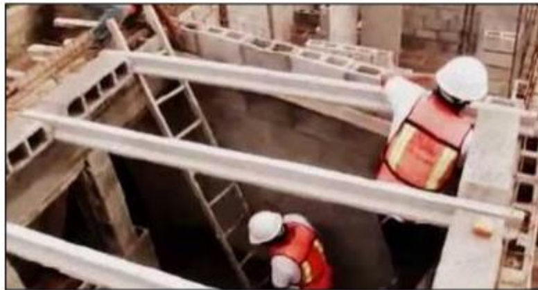
Figura 06: Colocación de bovedillas desde los extremos
