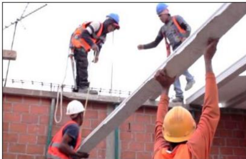
Figura 05: Montaje de viguetas pretensadas
