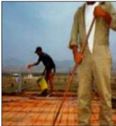
Figura 10: Limpieza y mojado de losa
