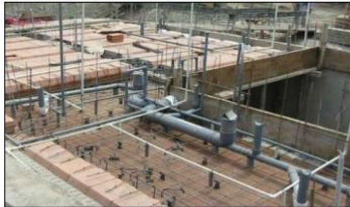
Figura 08: Instalaciones sanitarias con viguetas pretensadas
