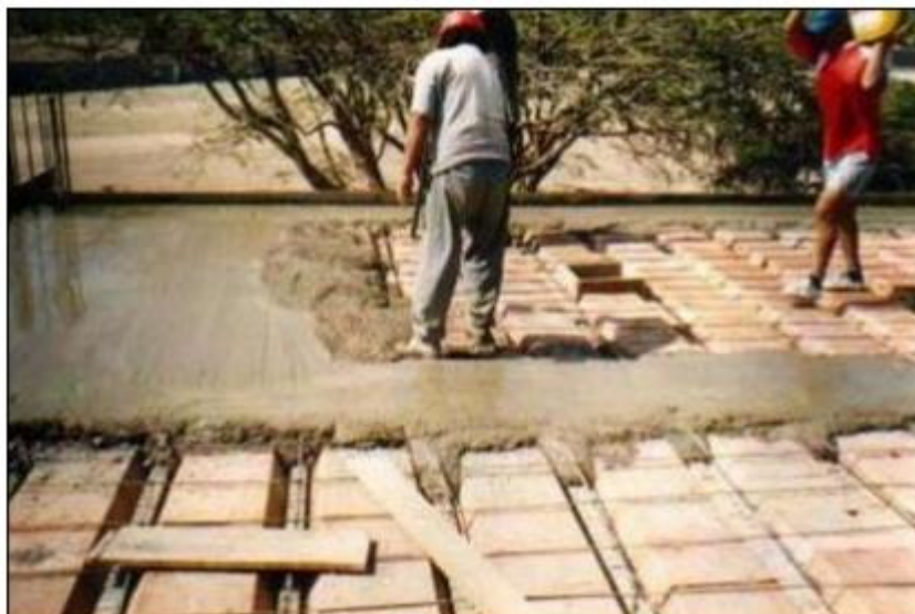
Figura 11: Vaciado de concreto sobre losa
