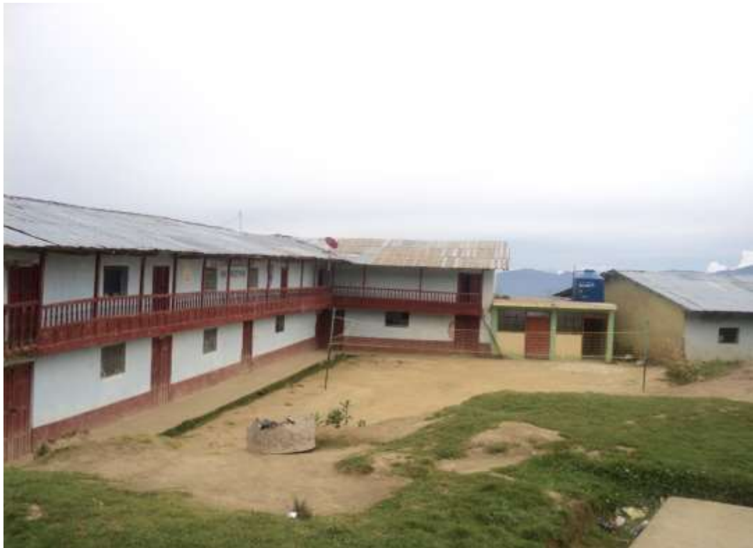
Se aprecia las aulas existentes de adobe a demoler
