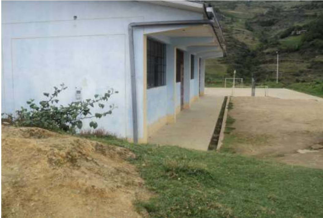
Se aprecia aulas a conservar
