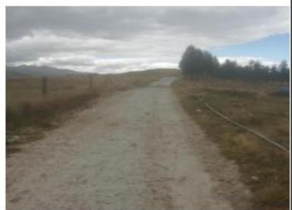
Foto N° 11: Huellas/hundimiento  $\geq 10$  cm (Progresivas 9+500 – 9+750)
