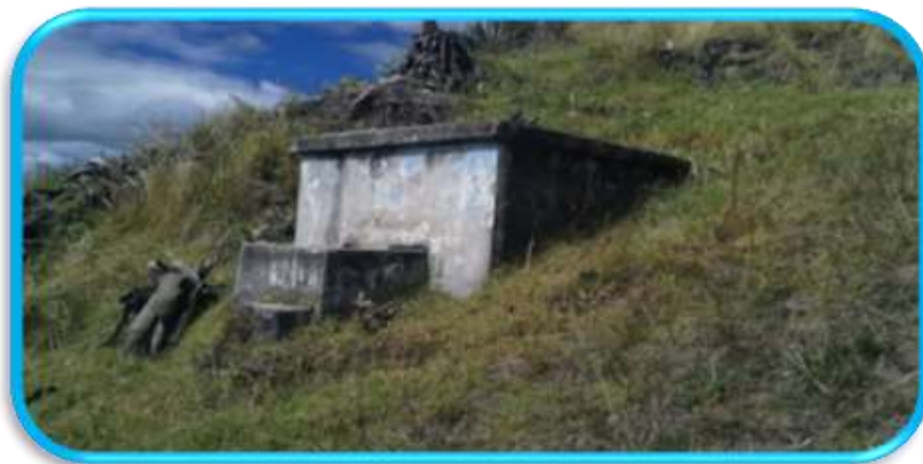
Figura . Reservorio existente - antigüedad 11 años
