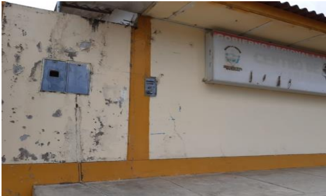
AMBIENTE O MODULO: FRONTIS Y CERCO PERIMETRICO DEL CENTRO DE SALUD CARABAMBA
