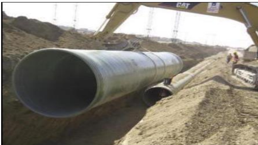
Figura 4. Colocación de tubería de drenaje
