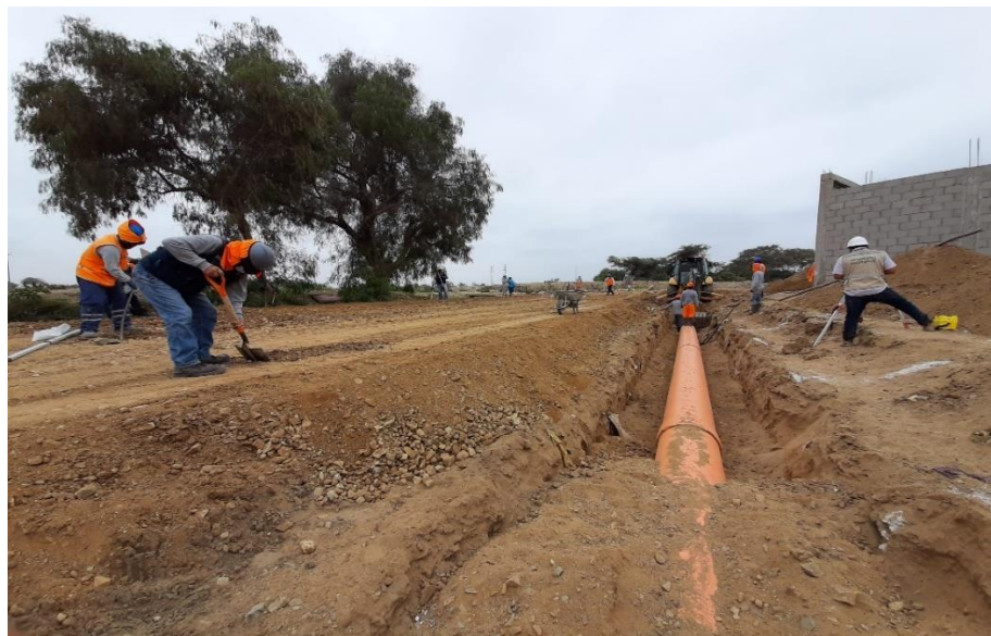
Figura 12 Colector troncal _ Tendido de Tubería \Phi 630 mm
