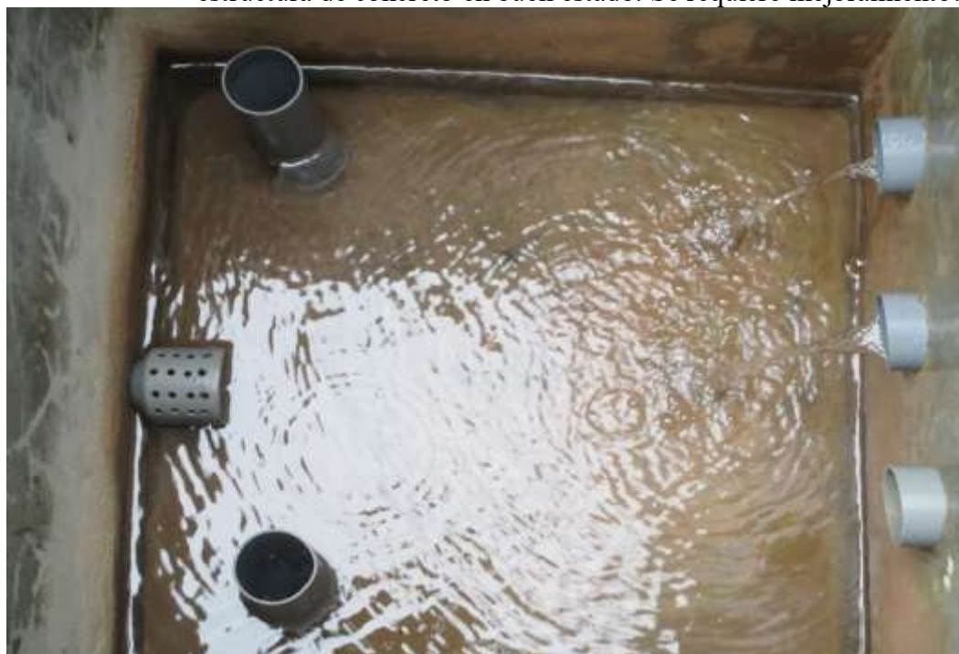
FOTO N° 02. – Vista Interior de la CAPTACION N° 1 “MONTEGRANDE”
