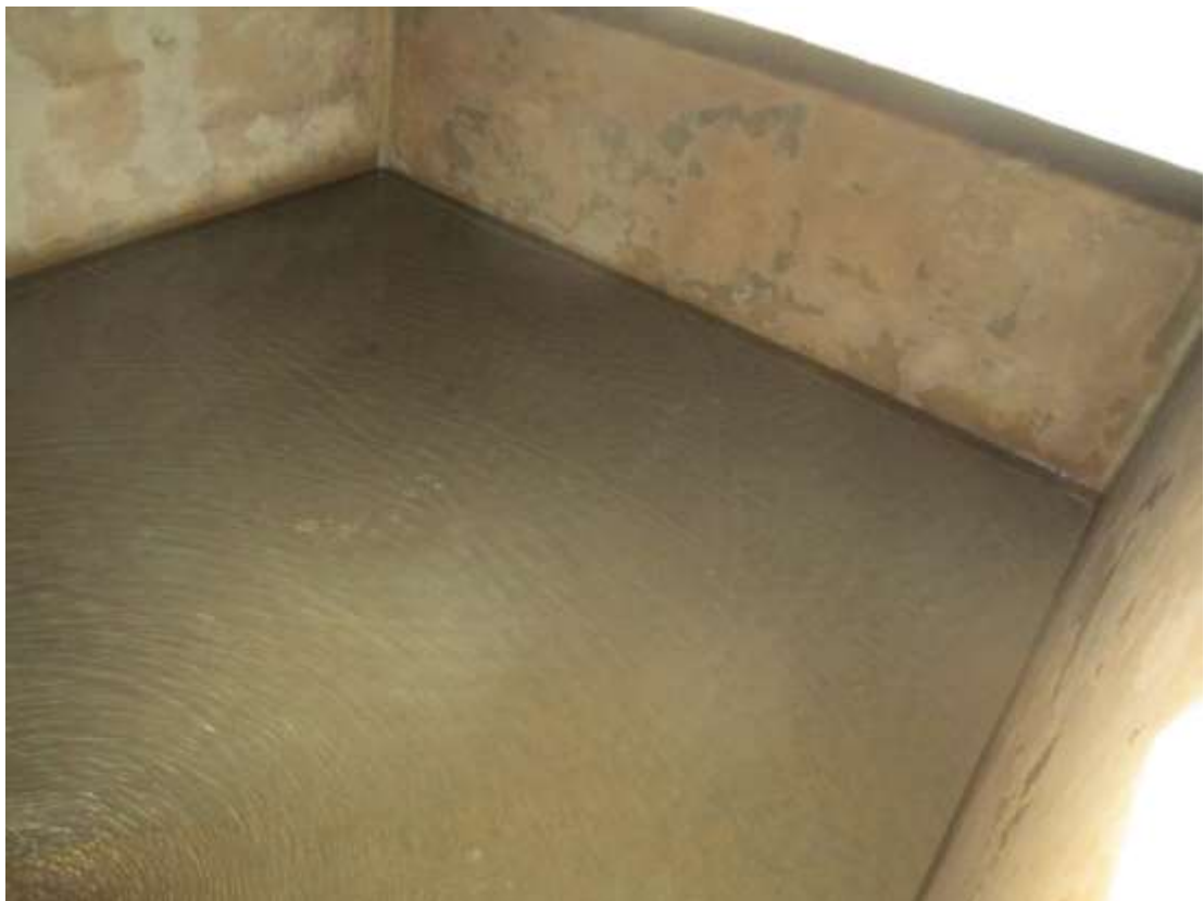
FOTO N° 06. - Vista interior de RESERVORIO N° 1 ( V=8M^3 ).
