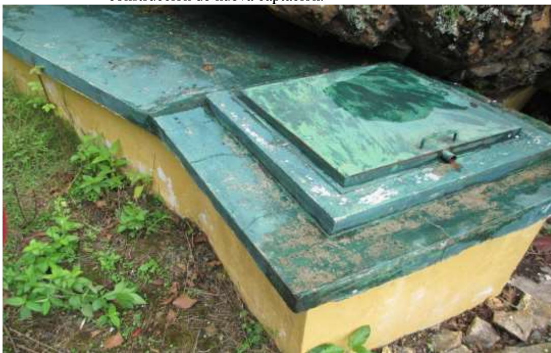
FOTO N° 14. -Verificación de la CAPTACION N° 4 “LA GRANADILLA”, como se aprecia se encuentra en buen estado estructural.
