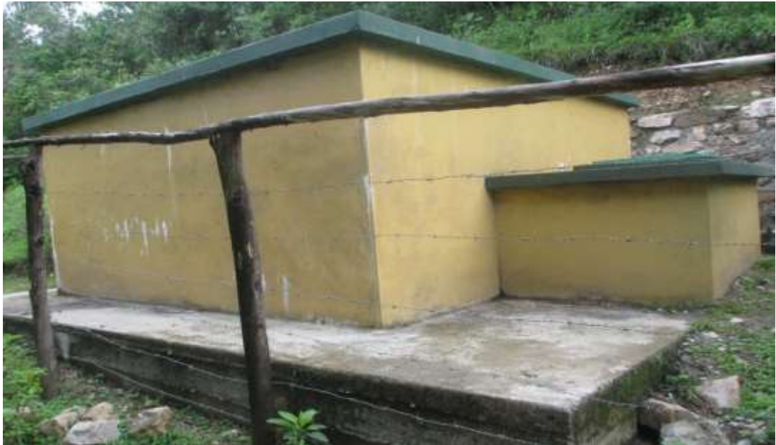
FOTO N° 08. - Verificación del Reservorio N° 2, V=12M3 SECTOR CATILLAMBI, SECTOR MOLLEPATA ALTA. Buen estado estructural, se requiere mejoramiento.
