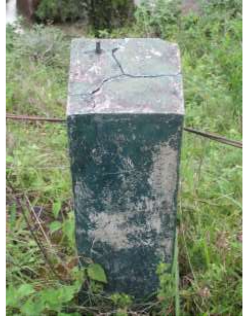
FOTO N° 19. - Vista de tubería rota con fugas y estructura de concreto deteriorada en PASE AEREO.
