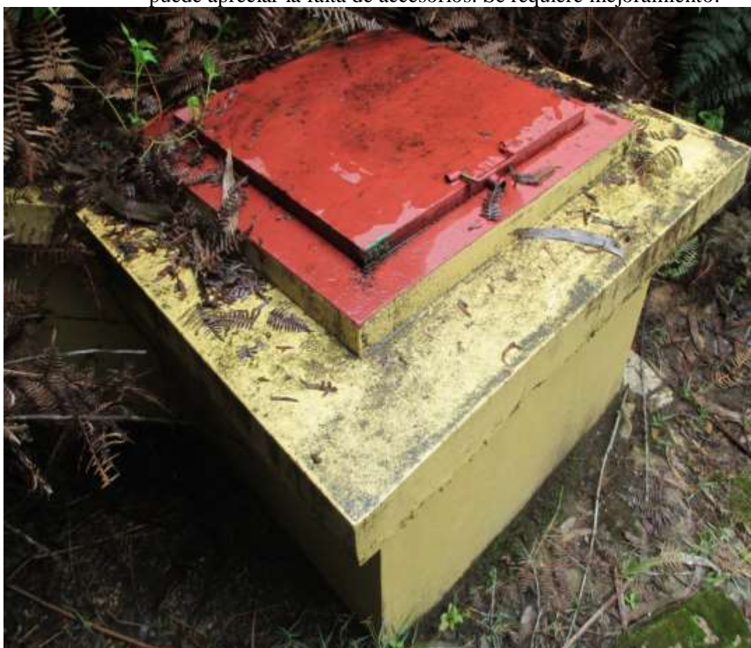
FOTO N° 16. - Verificación de la CAPTACION N° 5 “LA SHITA”, se aprecia el buen estado estructural de la misma.
