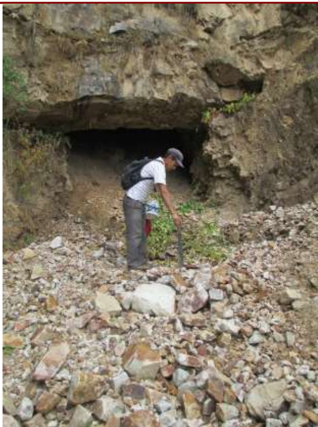
FOTO N° 13. - Ubicación de la CAPTACION N° 3 “EL VOLADERO”, la cual se encuentra enterrada debido a un deslizamiento. Se requiere la construcción de nueva captación.
