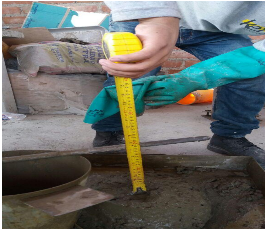
Anexo N° 21.. Medida de slump.
