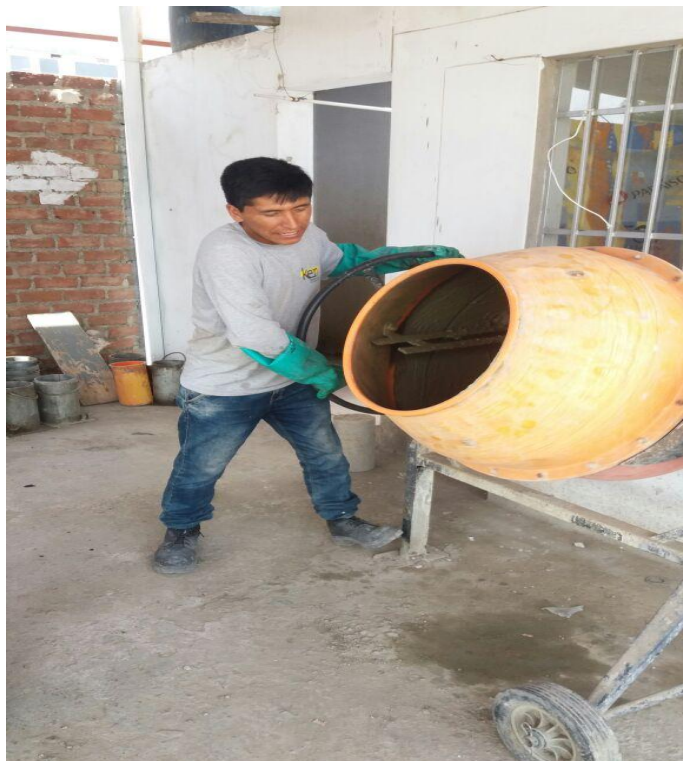
Anexo N° 17. Preparación de la mezcla en el trompo.
