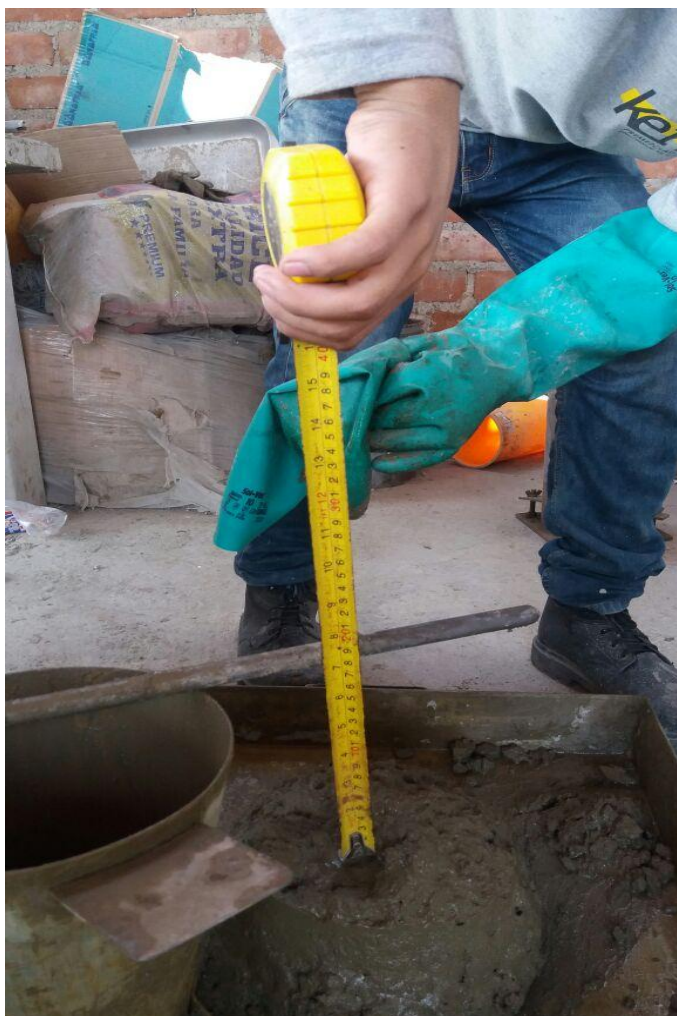
Figura 35. Trabajabilidad del concreto (slump)
