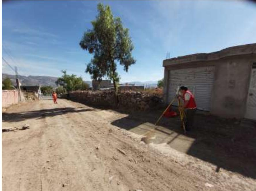
*Nota. La imagen muestra el levantamiento topográfico en la vía para el diseño del pavimento rígido.*
