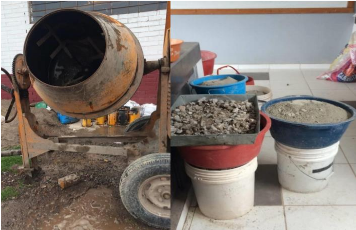
Fotografía 9 Trompo y material para el vaciado
