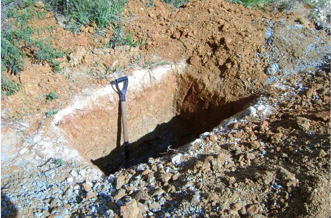
FOTO N° 08. EN ESTA VISTA PANORAMICA SE APRECIA PERSONAL REALIZANDO CALICATAS EN LA PROGRESIVA 20+000.
