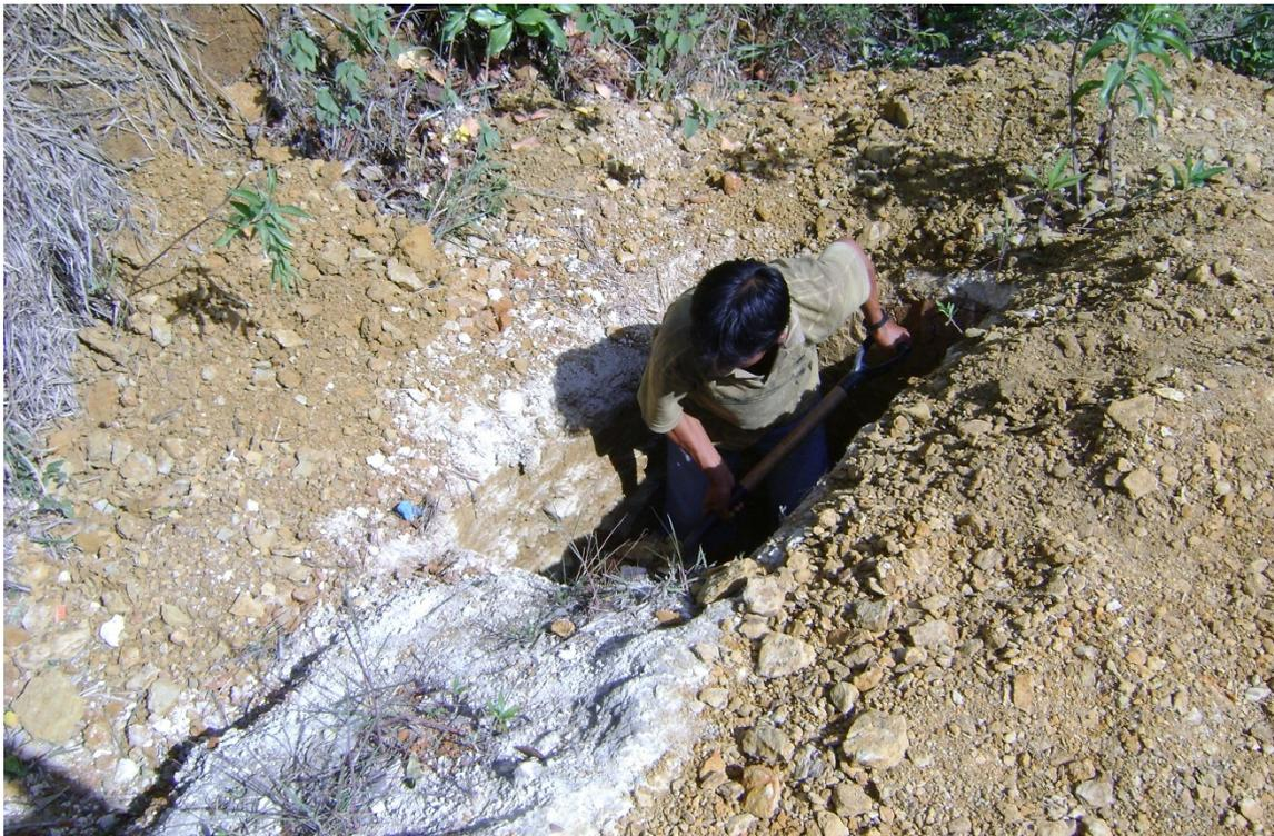
FOTO N° 07. EN ESTA VISTA PANORAMICA SE APRECIA PERSONAL REALIZANDO CALICATAS EN LA PROGRESIVA 7+000.
