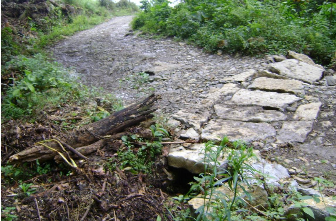
FOTO N° 06. EN ESTA VISTA PANORAMICA SE APRECIA ALCANTARILLA DE PIEDRA ACOMODADA QUE SERÁ CAMBIADA POR ALCANTARILLA TMC Ø36".
