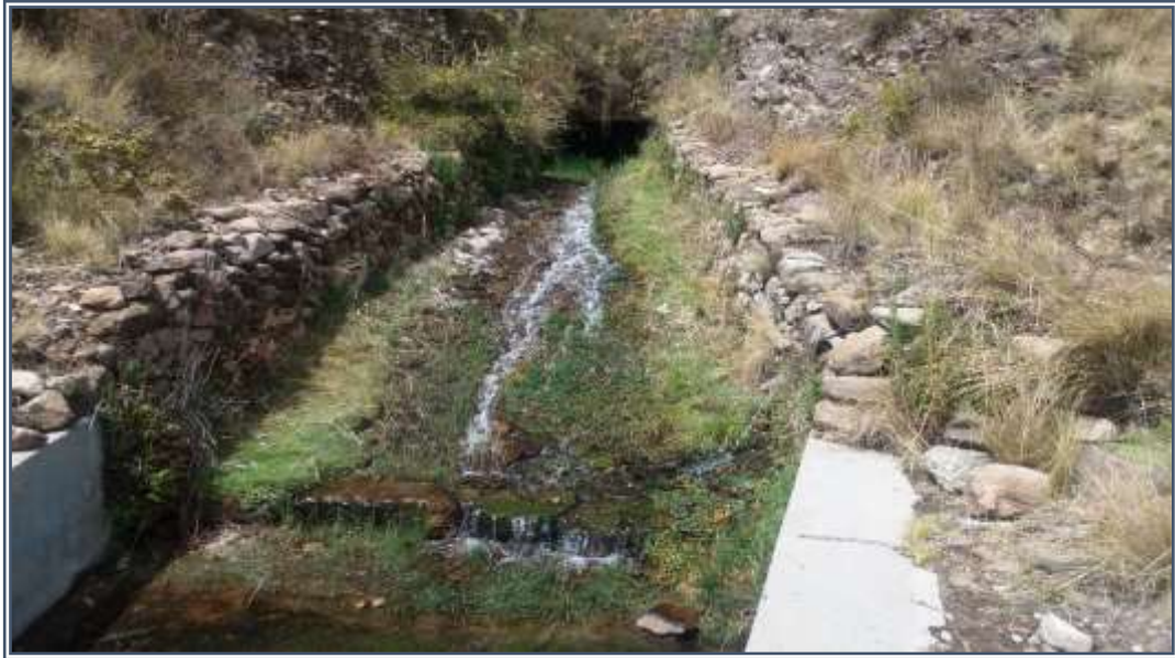
Figura N° 06 ubicación de la bocatoma central
