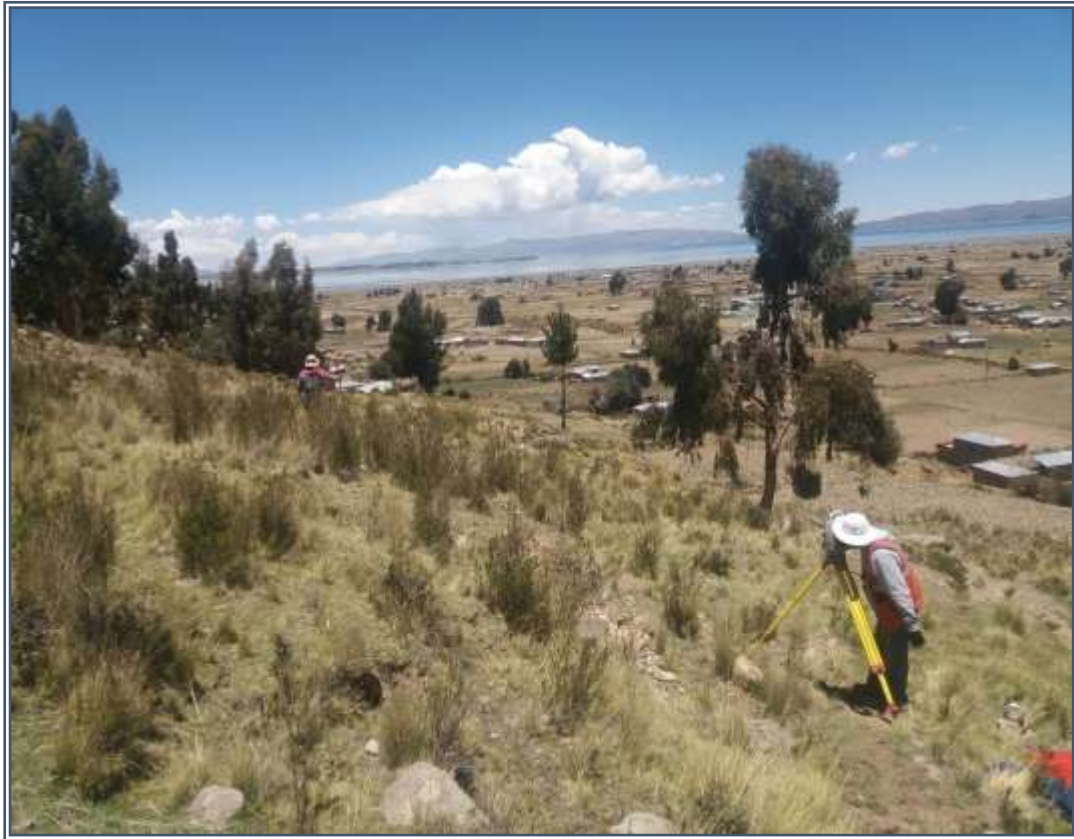
Figura N °10 trazo y replanteo
