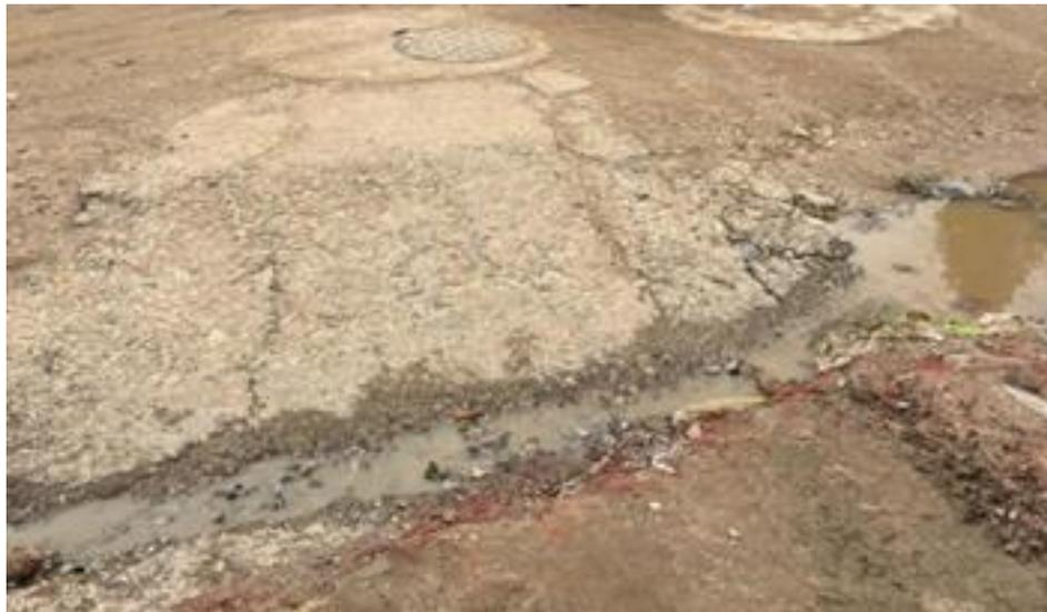
**IMAGEN 2:** Podemos apreciar que la pavimentación presenta desgaste debido a la falta de mantenimiento de las calles produciendo acumulación de flujos de agua de para la población y provocando focos a infecciosos.
