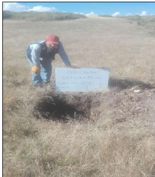
FIGURA N° 24 Excavación de calicata PC- 2
