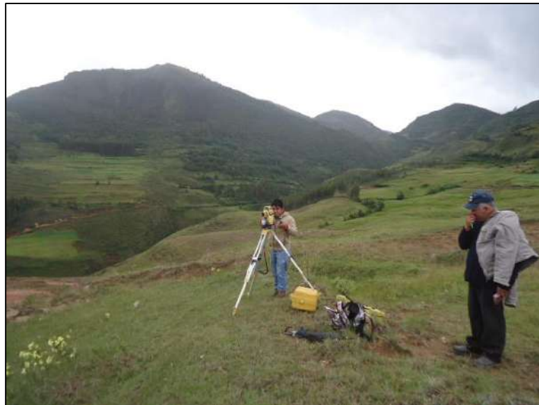
FIGURA N° 23 Levantamiento topográfico con estación total
