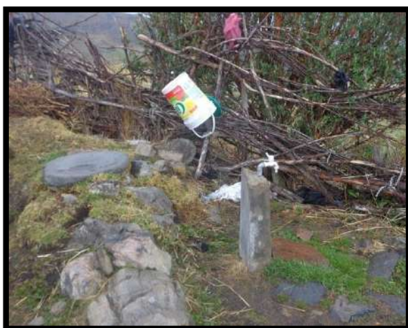
FOTO N° 9: Piletas domiciliarias en malas condiciones.
