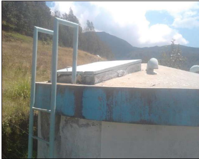
FIGURA N° 20 Estado crítico del reservorio
