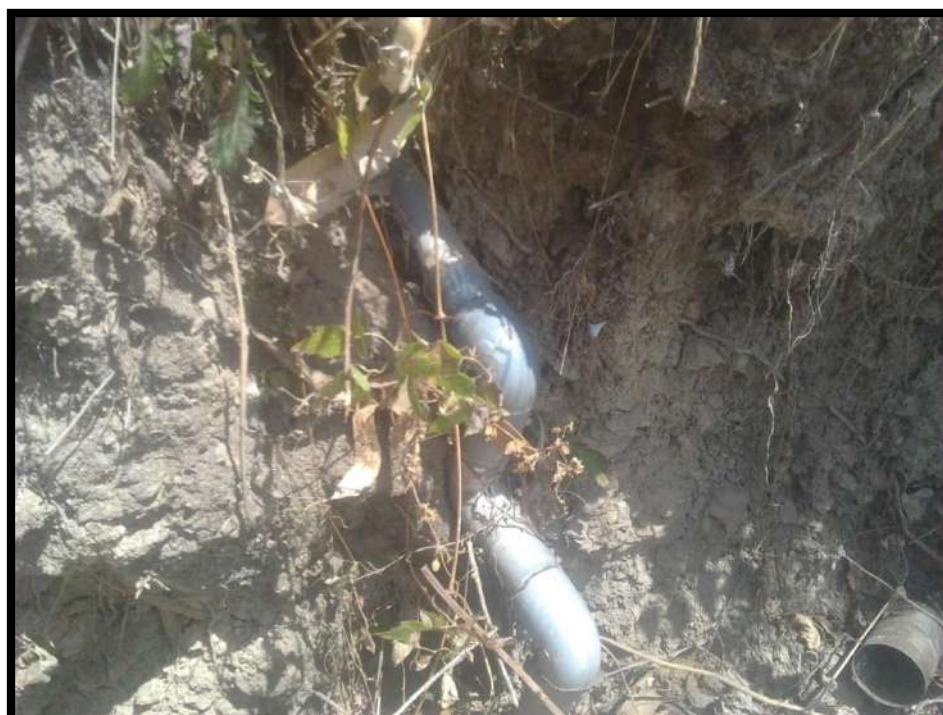
FOTO N° 5: Tuberías de conducción en los anexos Bello Horizonte y Cara, expuesta a la intemperie y en condiciones deterioradas.
