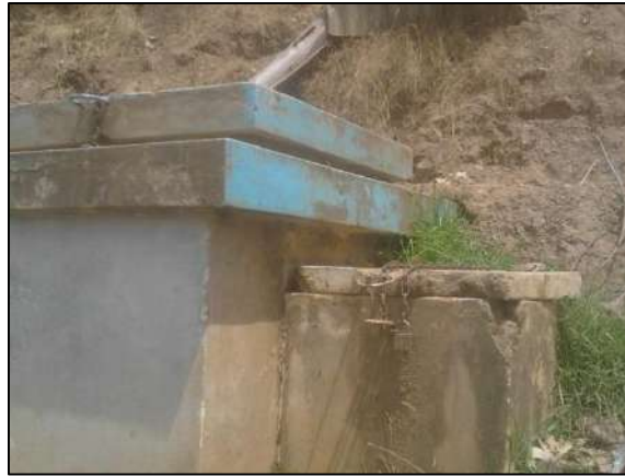
FIGURA N° 18 Estado crítico de la captación
