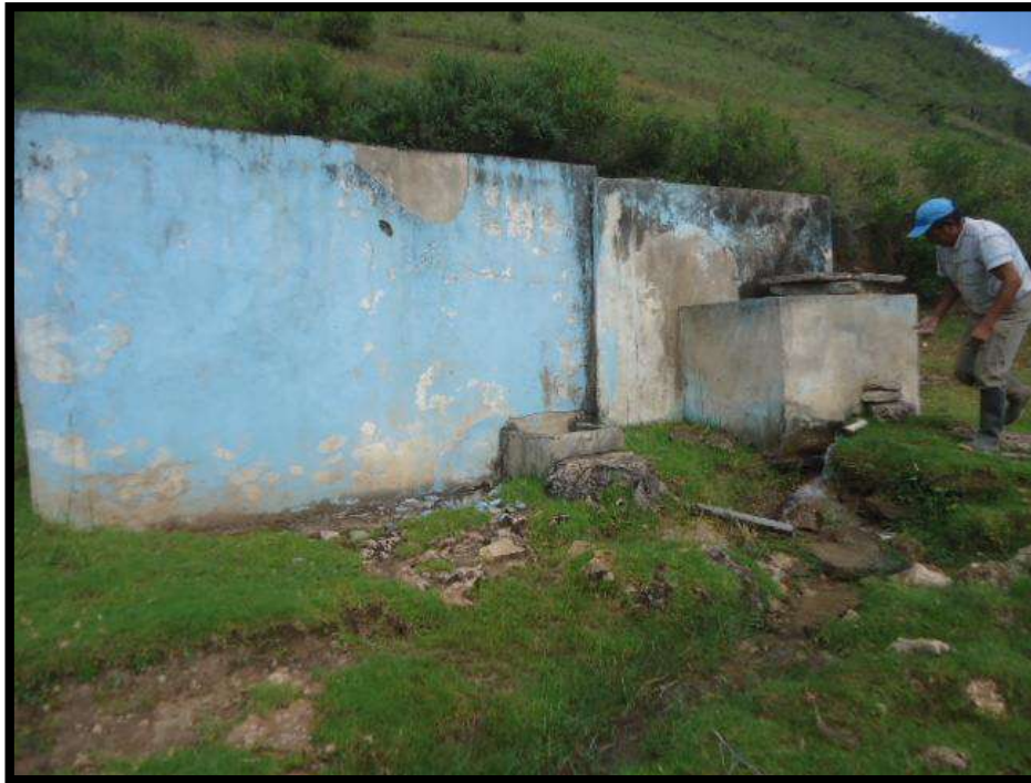
FOTO N° 6: Reservorios en los anexos Bello Horizonte y Cara, de concreto armado, en condiciones deterioradas debido a la falta de mantenimiento.
