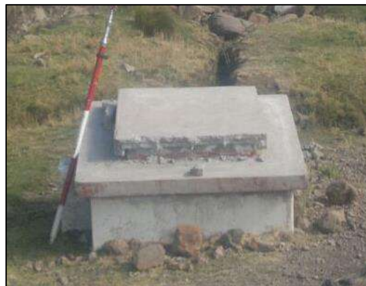
FIGURA N° 19 Estado crítico de la cámara rompe presión
