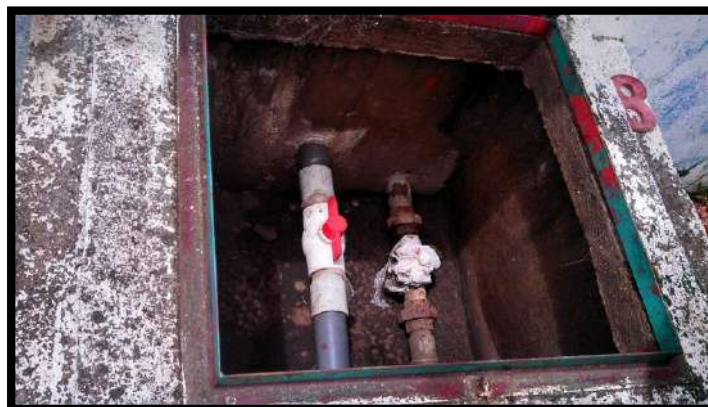
FOTO N° 7: Caseta de válvulas con accesorios oxidados.
