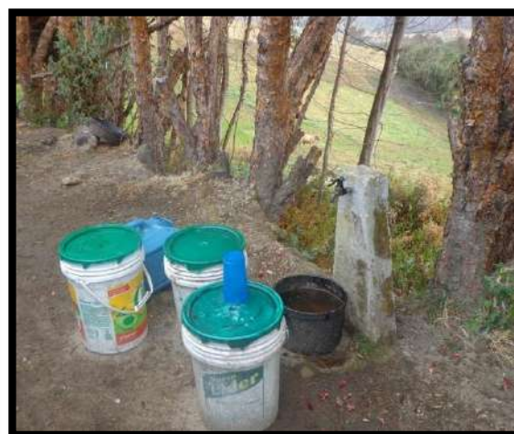
FOTO N° 9: Piletas domiciliarias en malas condiciones.
