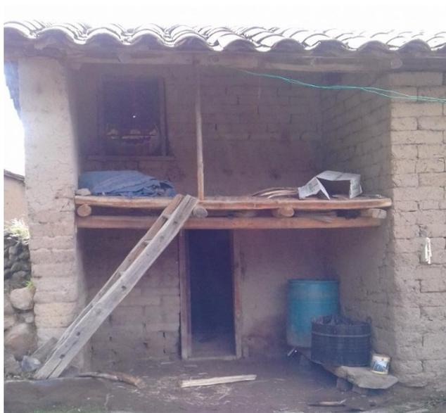
*Figura 26. VM-04 Bases Erosionadas*
