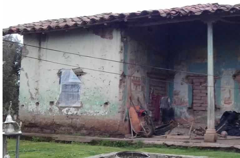
*Figura 28. VM-02 Bases Erosionadas*
