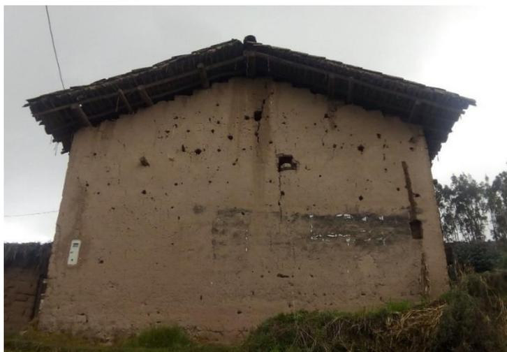
*Figura 29. VM-01 Muro Perforado*
