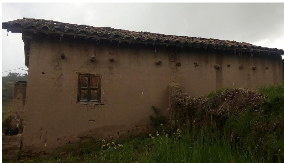
*Figura 27. VM-01 Bases Erosionadas*
