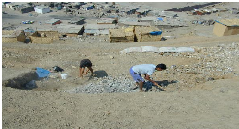
Figura 1: Nivelación del Lote
