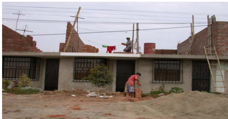
Figura 5: construcción de muros en el segundo piso
