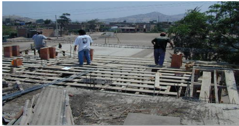
Figura 4: Encofrado del Techo
