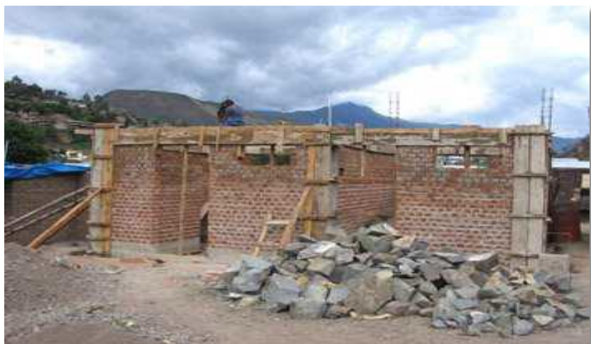
Figura 3: construcción de muros y llenado de columnas
