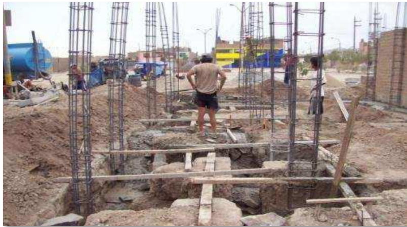
Figura 2: cimentación y armado de columnas
