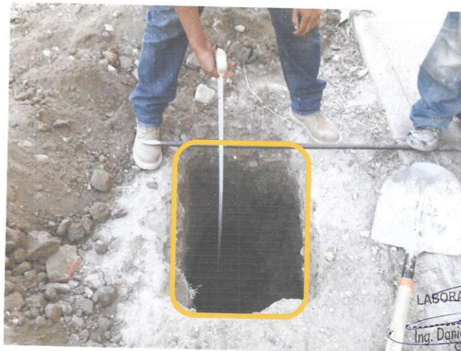
Foto N°02: Calicata don de aprecia el estrato existente.
