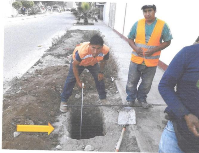
Foto N°01: Calicata verificando la profundidad a 1.80 m.
