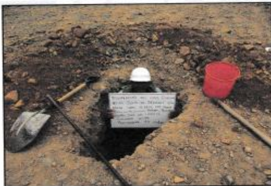
Foto N° 04. Perfil estratigráfico de calicata C - 2
