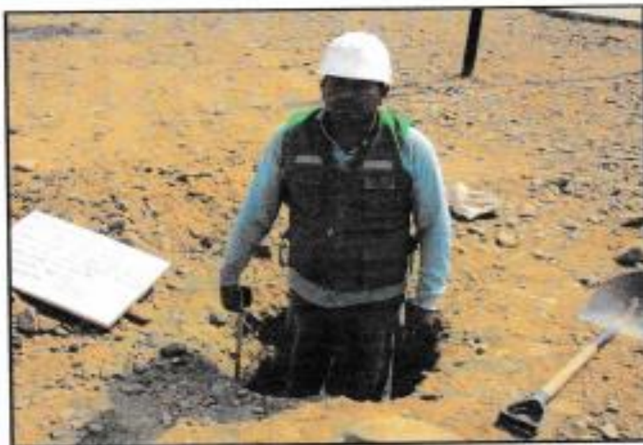
Foto N° 03. Ubicación de calicata C - 2
