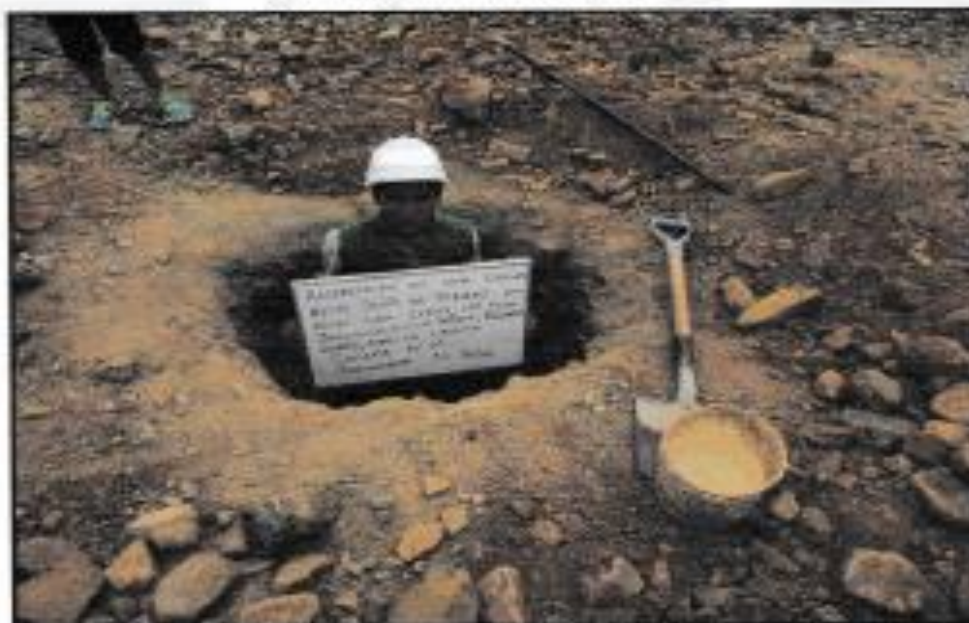
Foto N° 02. Perfil estratigráfico de calicata C-1
