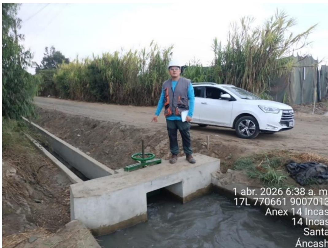
Figura 3 Progresiva inicial de la infraestructura hidráulica
