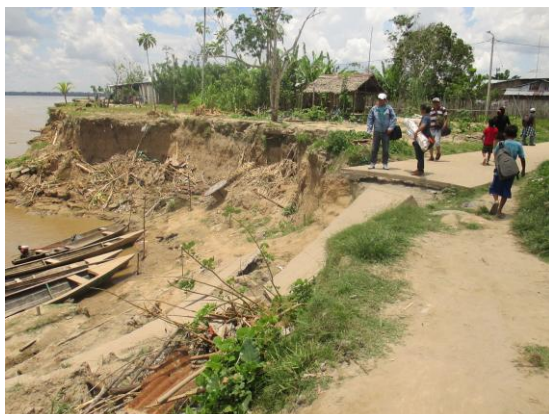
Foto N° 01. Zona erosionada en la margen del río Marañón. Fuente: El autor (2018)
